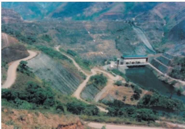
Embalse multipropósito de Salvajina para control de inundaciones y generación de energía eléctrica.
