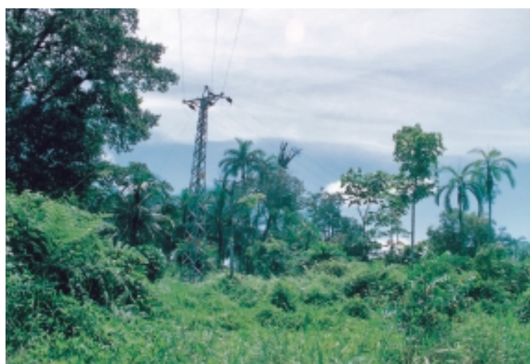
Electrificación en La Bocana.
