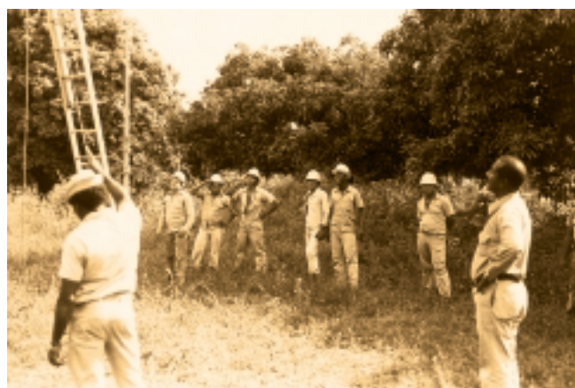
Tendida de redes para la interconexión Pasto – Tumaco
