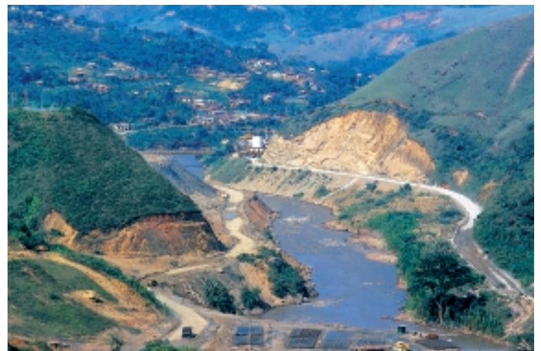
Proceso de construcción de la represa.
