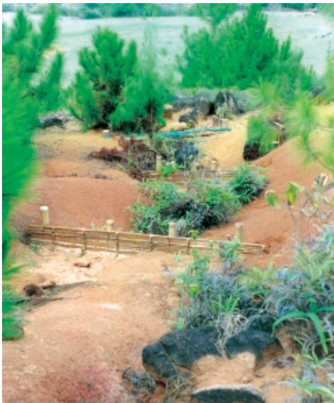
Recuperación de suelos mediante trinchos
