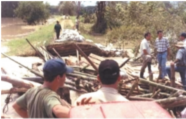
Falla de dique por hormigueros ocultos.
