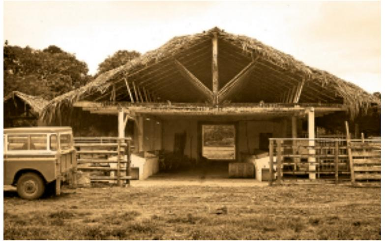
Muestra de un establo de bajo costo para ganadería de leche. Estructura en madera con techo de palmiche.
