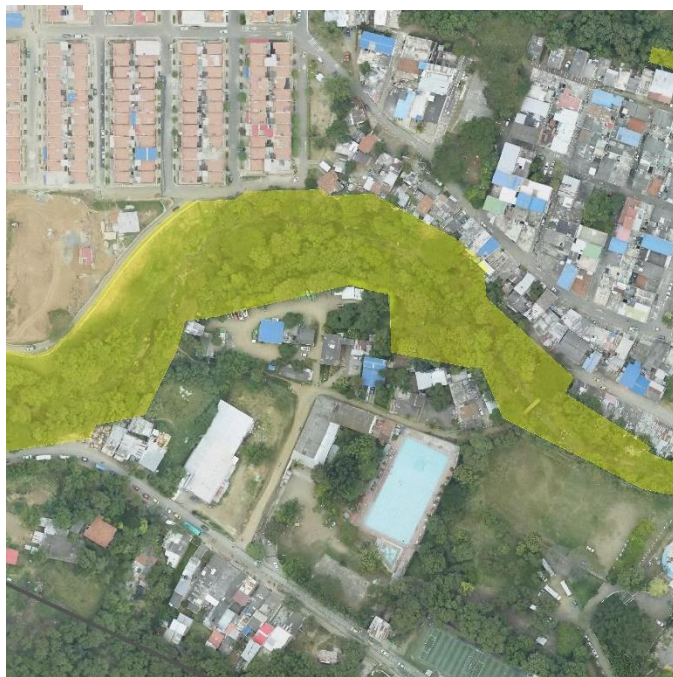
2 Sector Occidental, Barrio Dionisio
