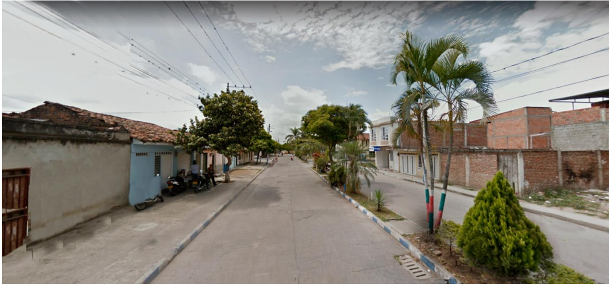
Figura 60. Vía Colectora Tipo 1 – Fotografía de la Situación Actual Fuente: Google Street View
