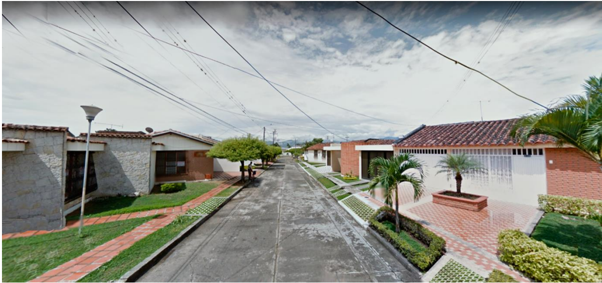
Figura 57. Calle Local Tipo 4 – Fotografía de la Situación Actual Fuente: Google Street View
