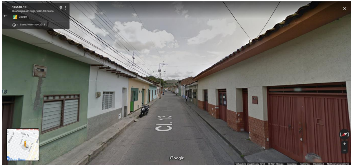
Figura 51. Calle Local Tipo 2 – Fotografía de la Situación Actual Fuente: Google Street View
