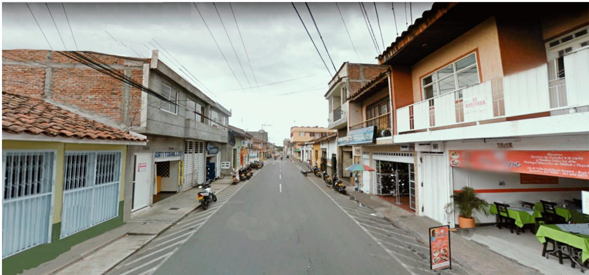
Figura 54. Calle Local Tipo 3 – Fotografía de la Situación Actual Fuente: Google Street View
