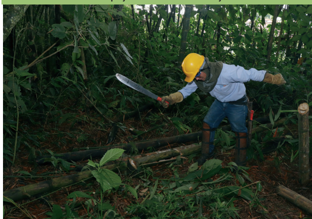
Ilustración 43. Despeje del área de trabajo
