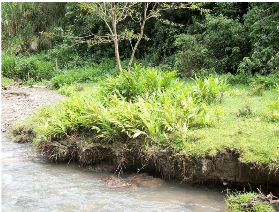
FIGURA 5.290. Aspecto general del paisaje en el complejo MPZV-D. (Fotografía: Reinaldo Ríos, 2018).
