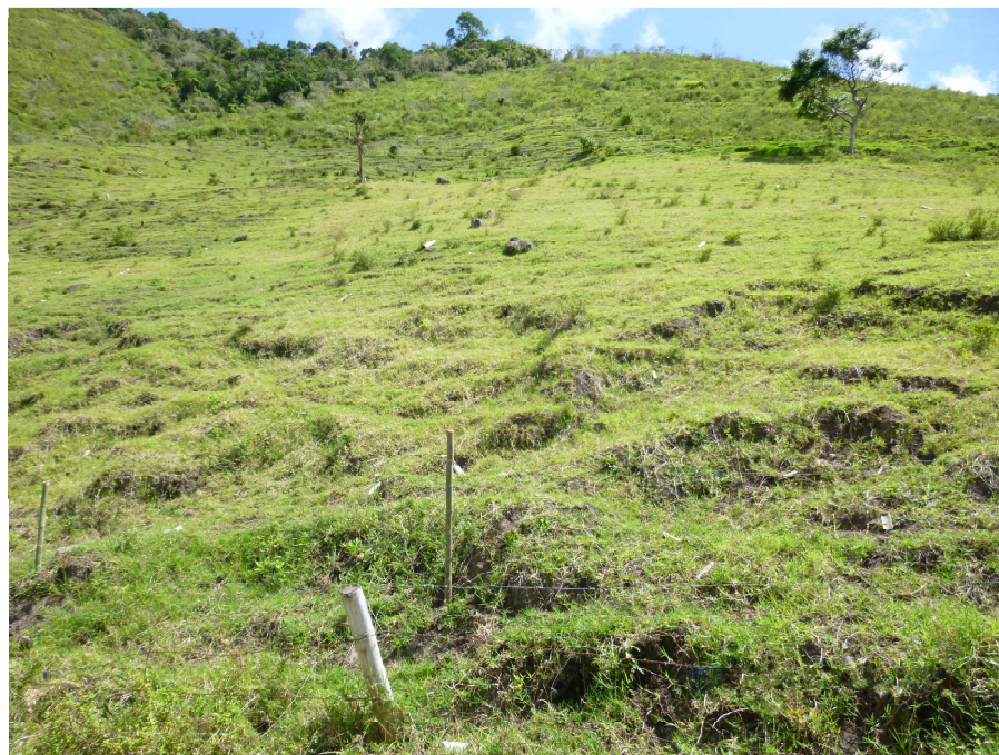
FIGURA 2.15. Ladera coluvial de fila y viga en alteritas de rocas ígneas extrusivas máficas, corregimiento El Naranjal - Bolívar (Valle del Cauca) Fuente: Samacá, W. (2017).
