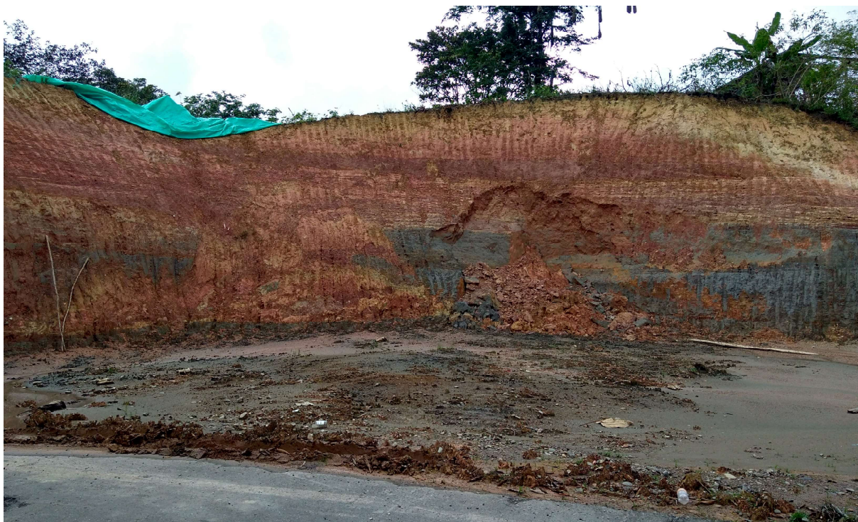
FIGURA 2.35. Lomas en alteritas de areniscas y conglomerados de la Formación Raposo, zona rural de Buenaventura (Valle del Cauca). Fuente: Gutiérrez, J. (2017).
