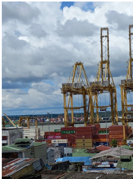
FIGURA 1.14. Puerto de Buenaventura (Fotografía Marco Velandia, 2022)
