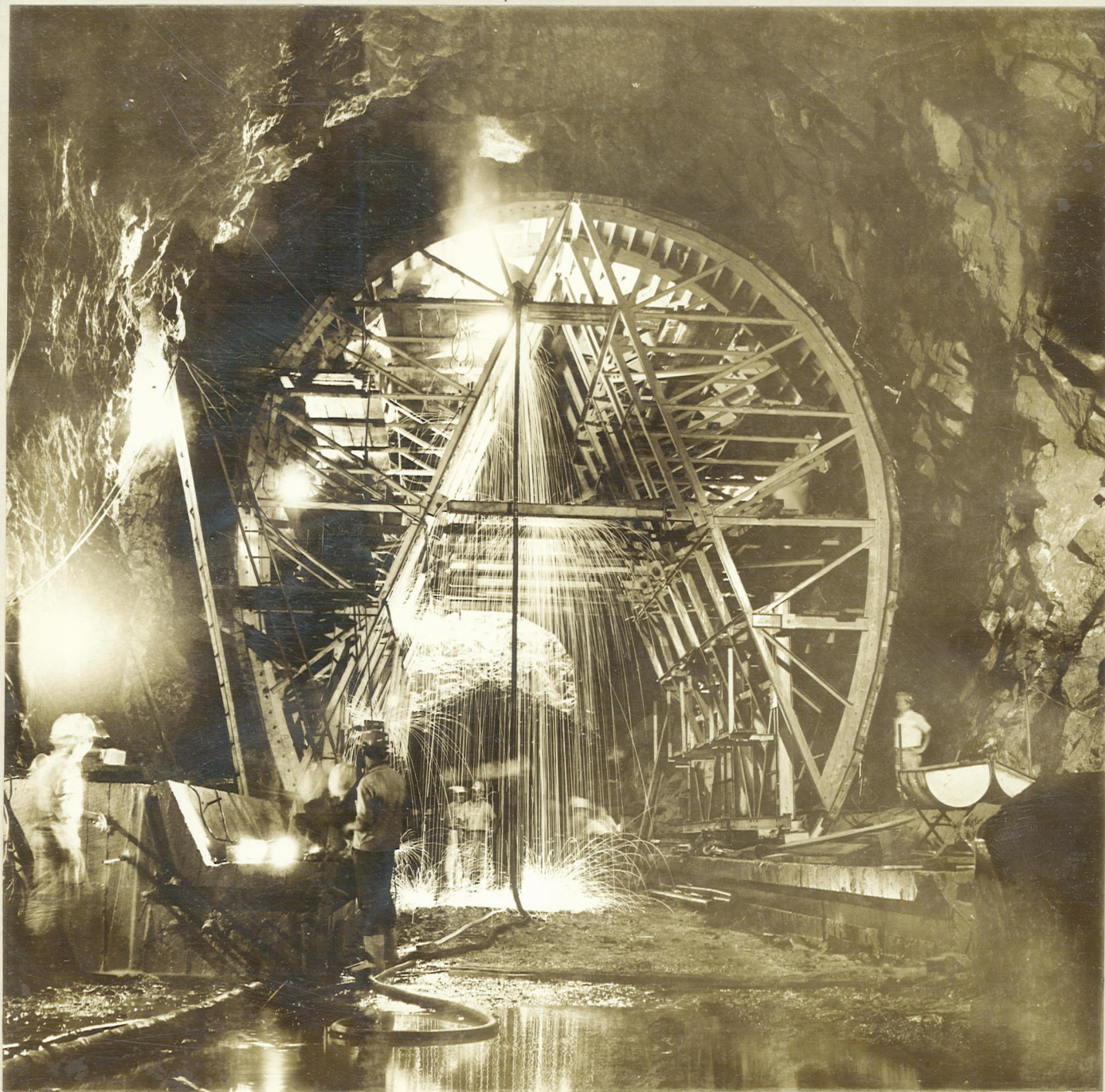
1. TUNEL DE DESVIACION EN EL AREA DE LA PRESA. Colocación de la Formaleta
