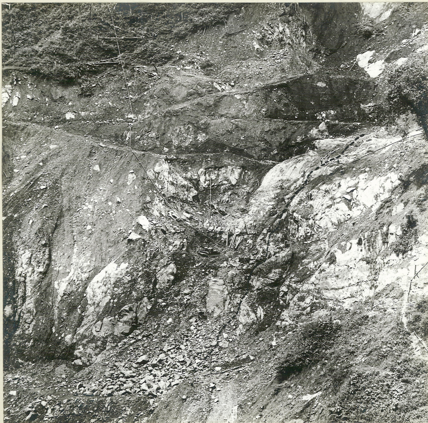
7. EXCAVACION PARA LA BOCATOMA Vista desde El Rebosadero
