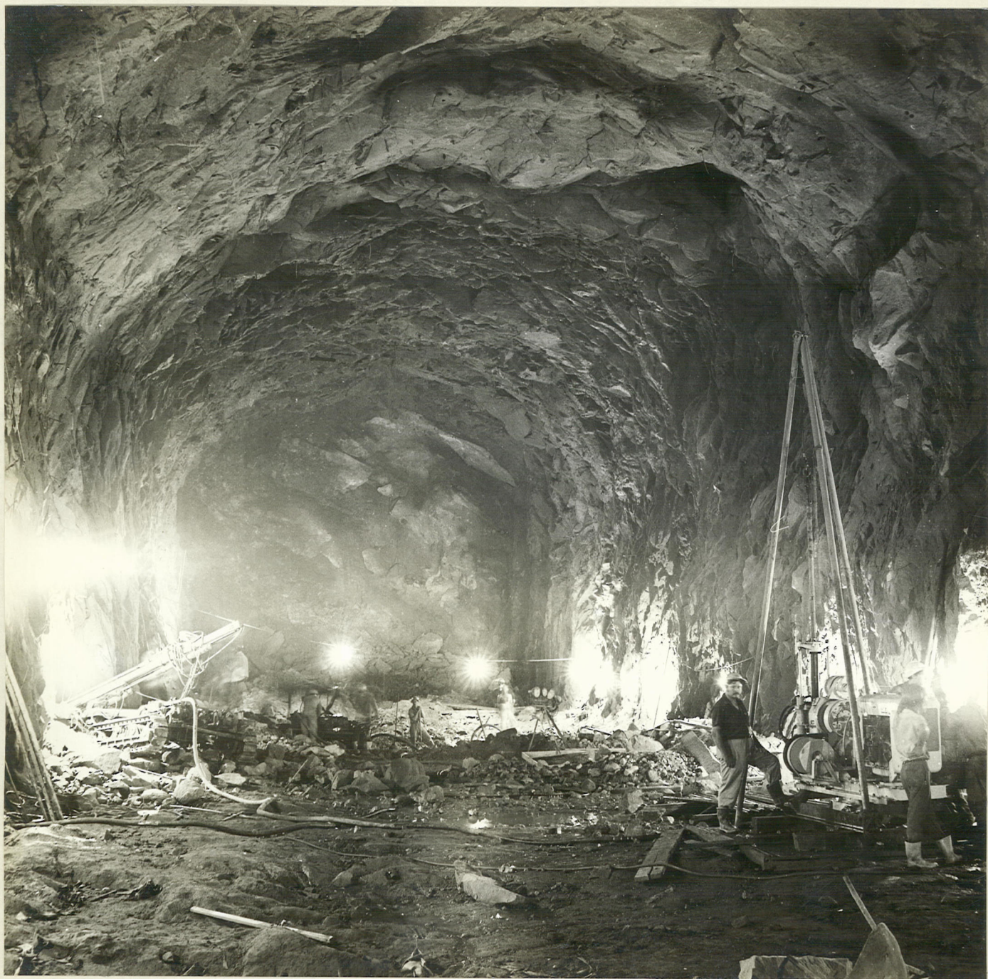
4. GALERIA DE TRANSFORMADORES. Area de Casa de Máquinas
