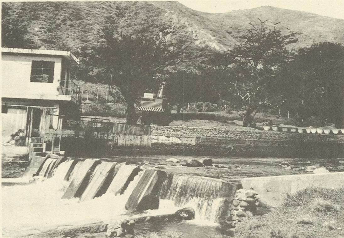
FOTOGRAFIA # 3 . Bocatoma del Acueducto de San Antonio con el canal promedio que presenta el Río Cali.
