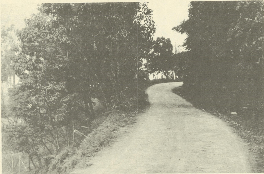
FOTOGRAFIA # 22. Carretera en buen estado. Vía El Saladito-Felidia
