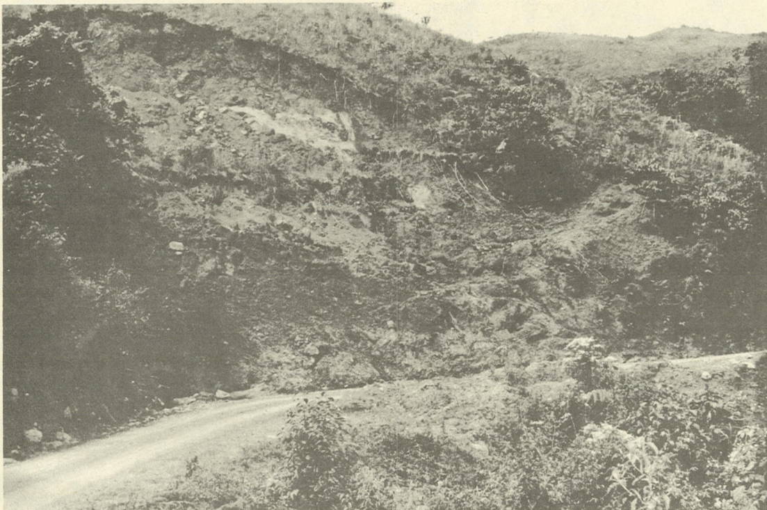
FOTOGRAFIA # 23. Carretera con problemas de derrumbes. Vía Cali-Pichindé.
