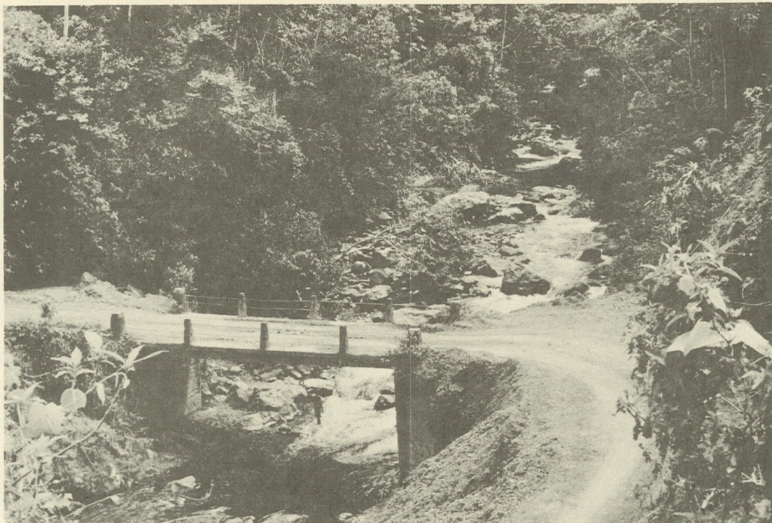
FOTOGRAFIA # 12. Río Pichindé y carretera que conduce de Puente Sofía a Los Cárpatos. Obsérvense las márgenes de la corriente bien protegidas.
