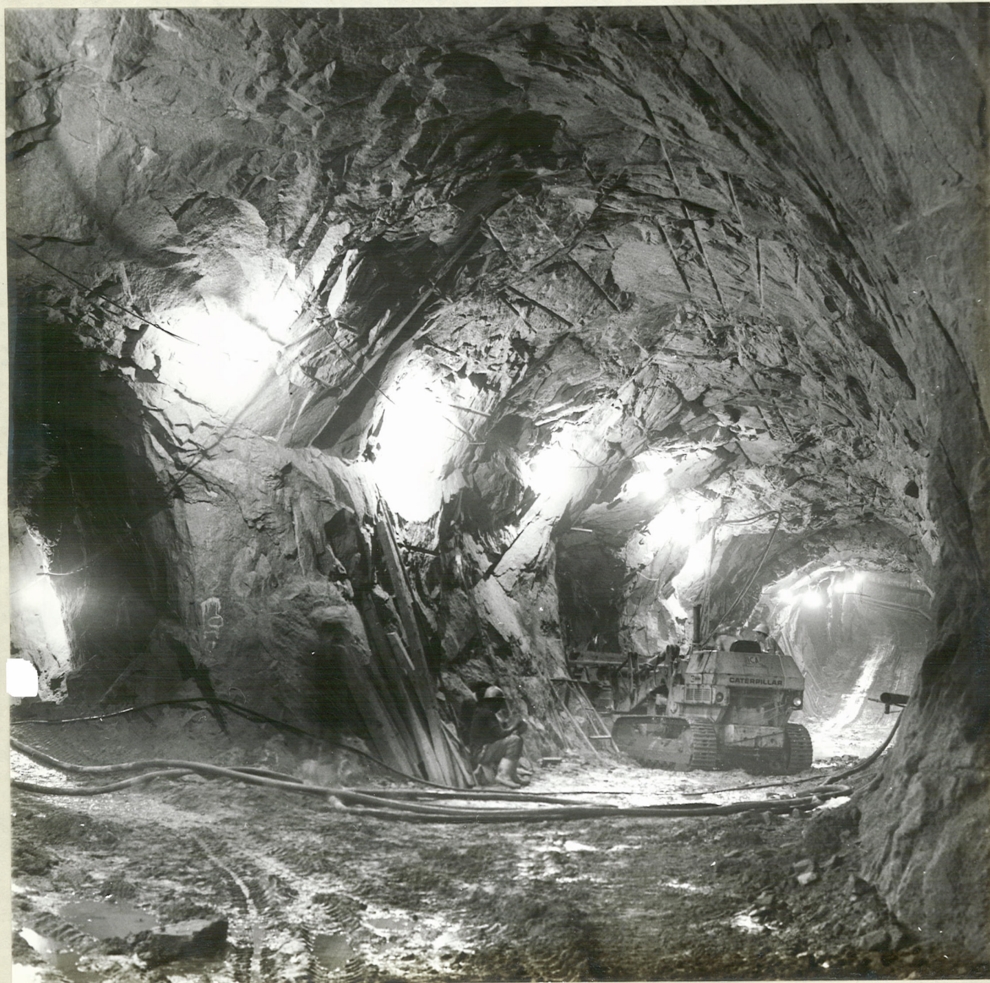
4. TUBERIA DE PRESION Trifurcación y Túnel de Acceso
