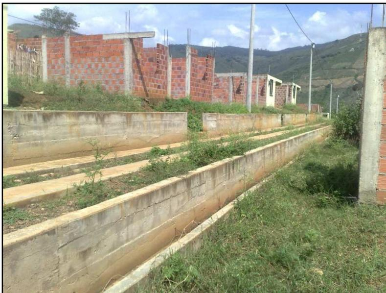
**Foto 3.5** canales de captación frente a las viviendas, los cuales impiden la entrada del agua conduciéndola hacia los desagües.
