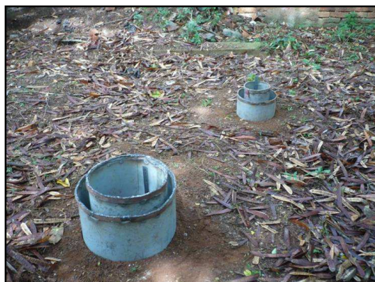
Foto 7.23 Prueba de infiltración; Barrio Chapinero.
