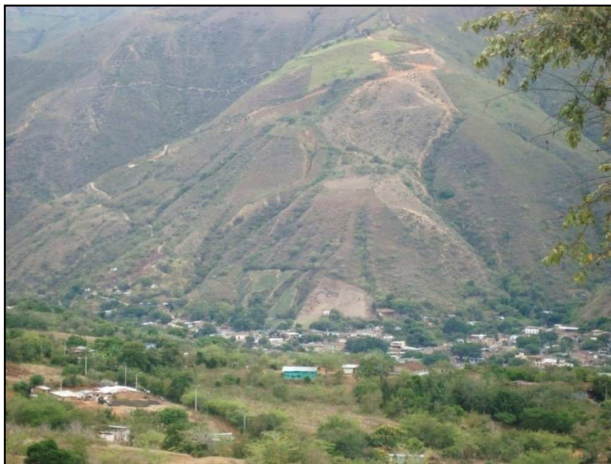
Foto 5.9 Deslizamiento traslacional muy antiguo, barrio Gran Colombia.
