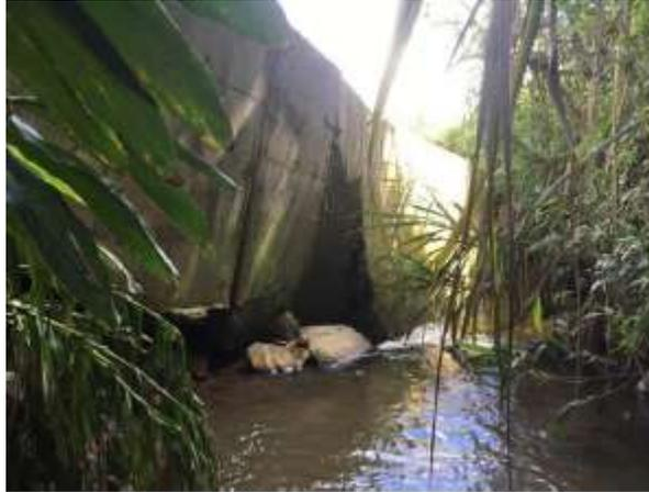
**Figura 9.2.** Ruptura a torsión del muro de contención en gaviones número 3
