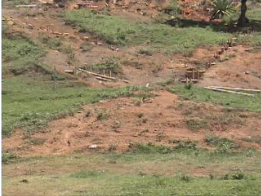
Foto 3. Control de erosión en la microcuenca de la quebrada Madrigal. ( Mayo 29/2003).
