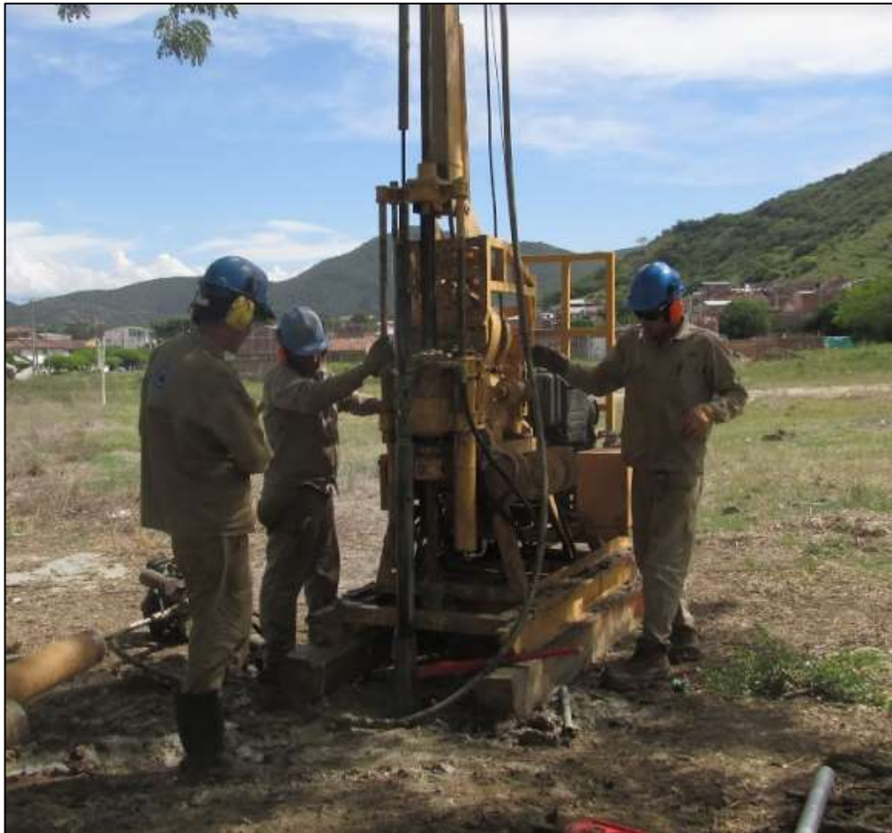
Figura 7.3. Máquina (JOY) usada para las perforaciones Fuente: fotografía propia.
