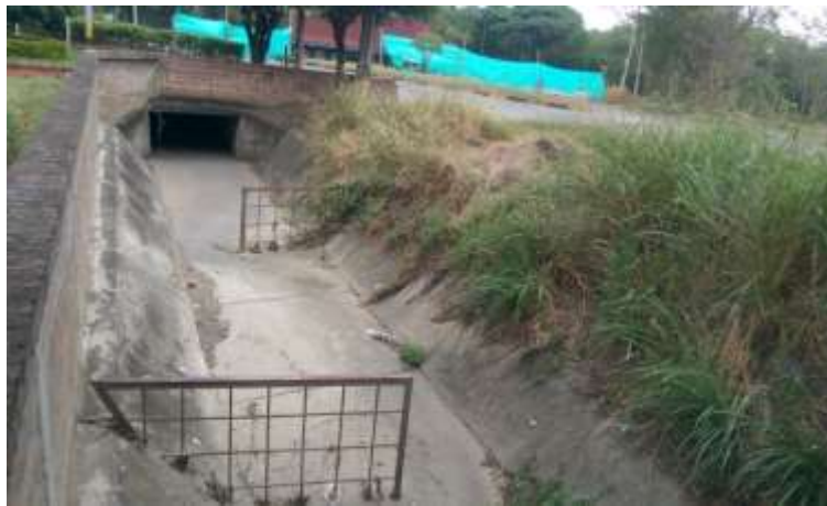
Figura 2.3. Zanjón Los Mudos, box culvert localizado sobre la glorieta de la vía Panorama Fuente: fotografía propia
