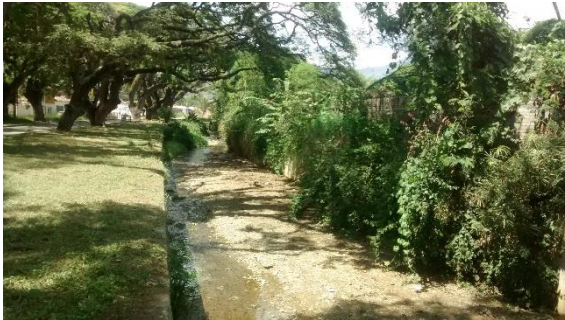
Río Roldanillo. Foto tomada aguas arriba del puente localizado carrera 10 con calle 10.
