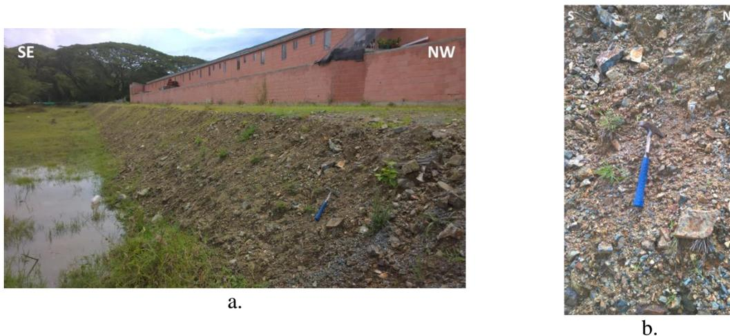
**Figura 57. a.** Aspecto de los Llenos de roca (Allr) sobre el cual se construyó el Conjunto Residencial Acacias (Portal del Valle) entre Etapas 2 y 3. **b.** Detalle del relleno de roca muerta. Estación R124.
