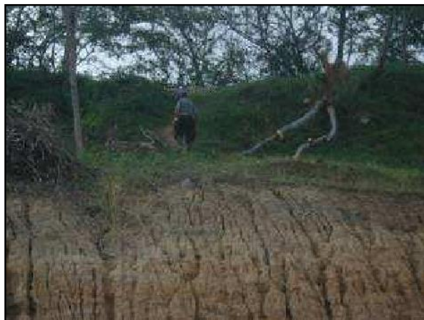
Foto 7.3 Erosión en el barrio Alto Bonito, cerca de la acequia Chambimbal.
