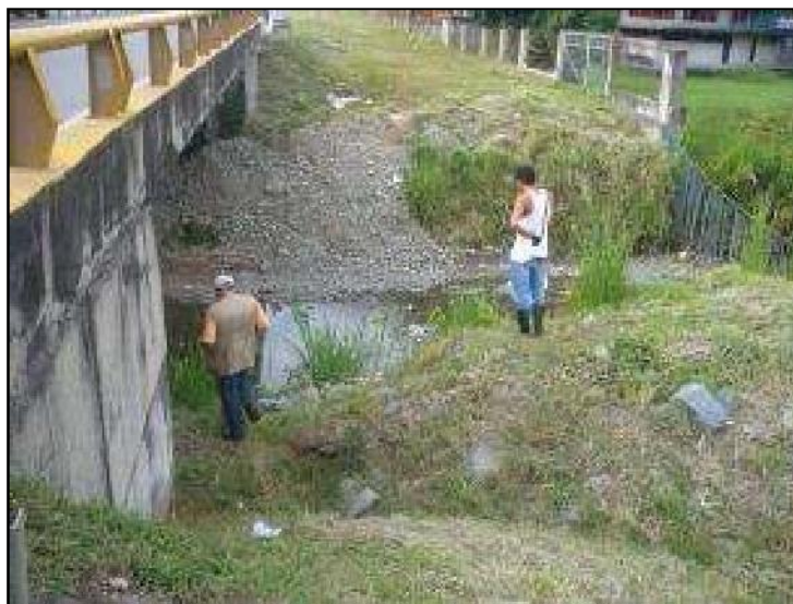
Foto 7.6 Aforo Quebrada Chambimbal; Puente vía Panorámica.
