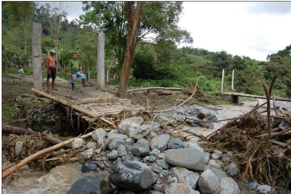
Foto 2.6 Puente destruido, vereda El Janeiro. Documentos del CLOPAD, 29 de Mayo de 2.009.
