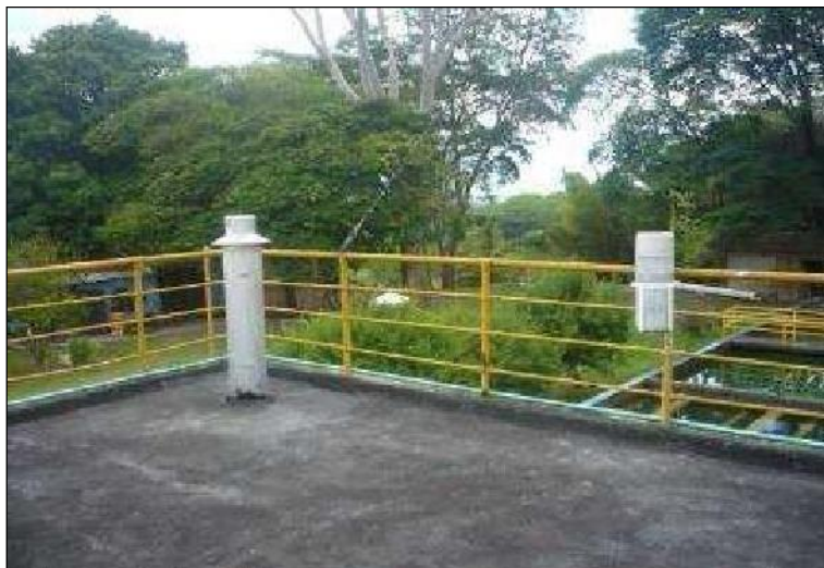
Foto 7.1 Estación Acueducto Buga.
