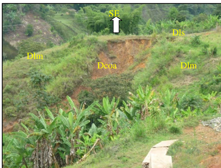
Foto 5.6 Vista hacia el sur oriente donde se observan las unidades Ladera moderada (Dlm), ladera suave (Dls) y deslizamiento activo (Dmm)
