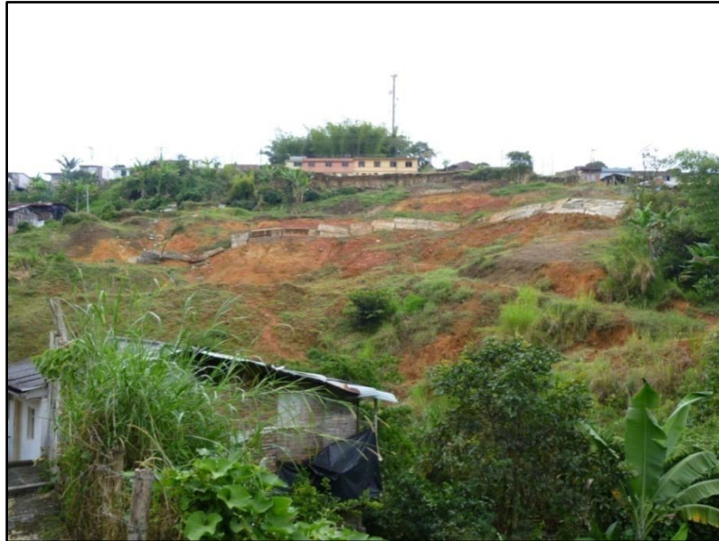
Foto 5.8 Panorámica general del movimiento que afecta al barrio Monserrate, se observa la corona principal en la parte alta, un muro de gabi6n destruido a media ladera y varios escarpes secundarios que evidencian movimientos de diferentes 6pocas.
