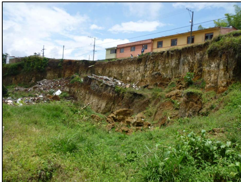
Foto 5.9 Corona del movimiento donde se observan niveles de cenizas volc6nicas cubriendo los suelos residuales de color rojo. Las viviendas est6n a escasos 10 metros del escarpe.
