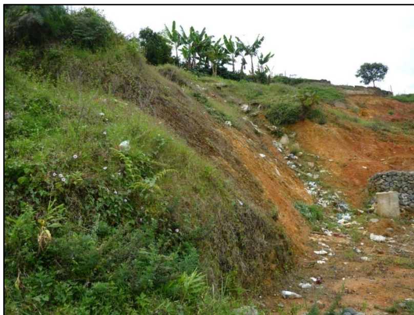
Foto 5.1 Suelos residuales de los basaltos y diabasas en uno de los Taludes del barrio Monserrate donde se observa el característico color naranja rojizo y el espesor que puede superar los 10 metros.
