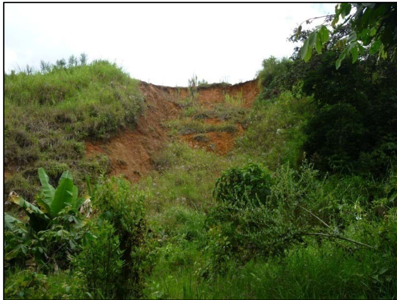
Foto 5.10 Vista general de un movimiento que se presenta al sur oriente del barrio Monserrate donde queda al descubierto la capa de suelos residuales de color rojo. La cobertura vegetal comienza a cubrir la zona.
