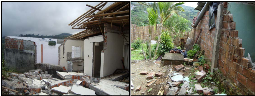
Fotos 3.1 y 3.2 Intensa destrucción de viviendas manzana 262 ocasionada por el movimiento en masa y progresivo del terreno, afectando fuertemente la cimentación de las viviendas. Fuente: Informe CVC, 2010
