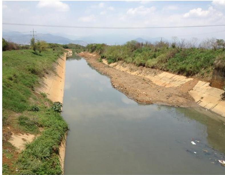
**Figura 21. Reducción de capacidad hidráulica del canal Interceptor Sur**
