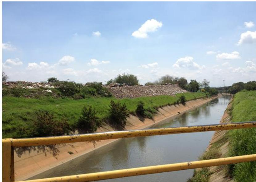
**Figura 20. Sobrecarga de dique generada por disposición de escombros sobre el canal Interceptor Sur**
