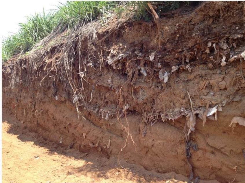
**Figura 17. Corte vertical evidenciando posterior relleno con basura en dique Canal Interceptor Sur**
