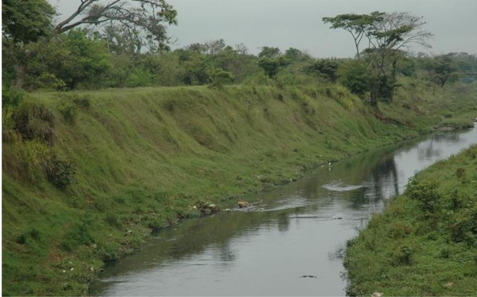
**Figura 15. Inclinación inapropiada de dique sobre la margen izquierda del canal Interceptor Sur**
