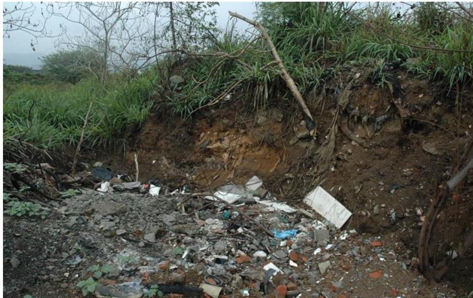
**Figura 16. Corte y botado de basura en dique sobre el canal Interceptor Sur**
