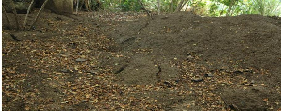
**Figura 9. Hormigueros sobre la berma y a través del dique en zona de Navarro**
