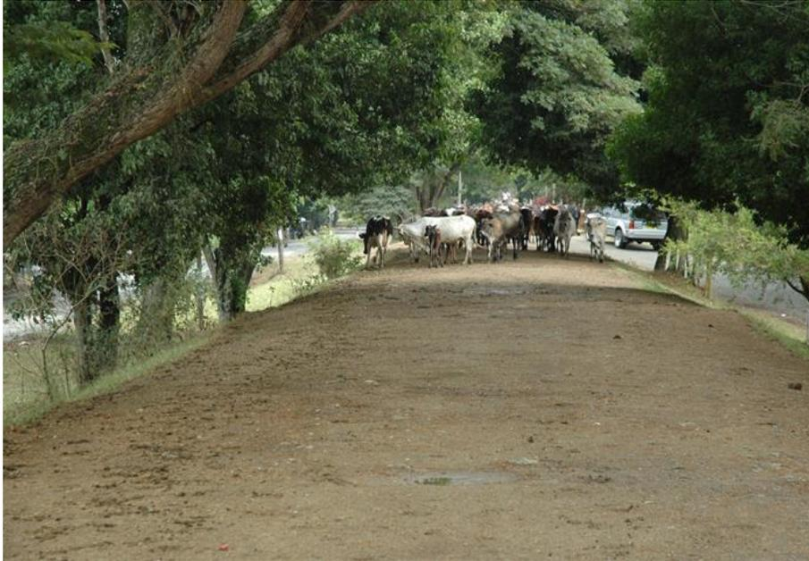
**Figura 11. Ganado caminando sobre dique en zona de Navarro, generando erosión**
