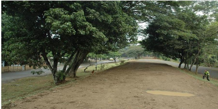
**Figura 10. Arboles localizado en lados húmedo y seco del dique sobre el río Cauca**
