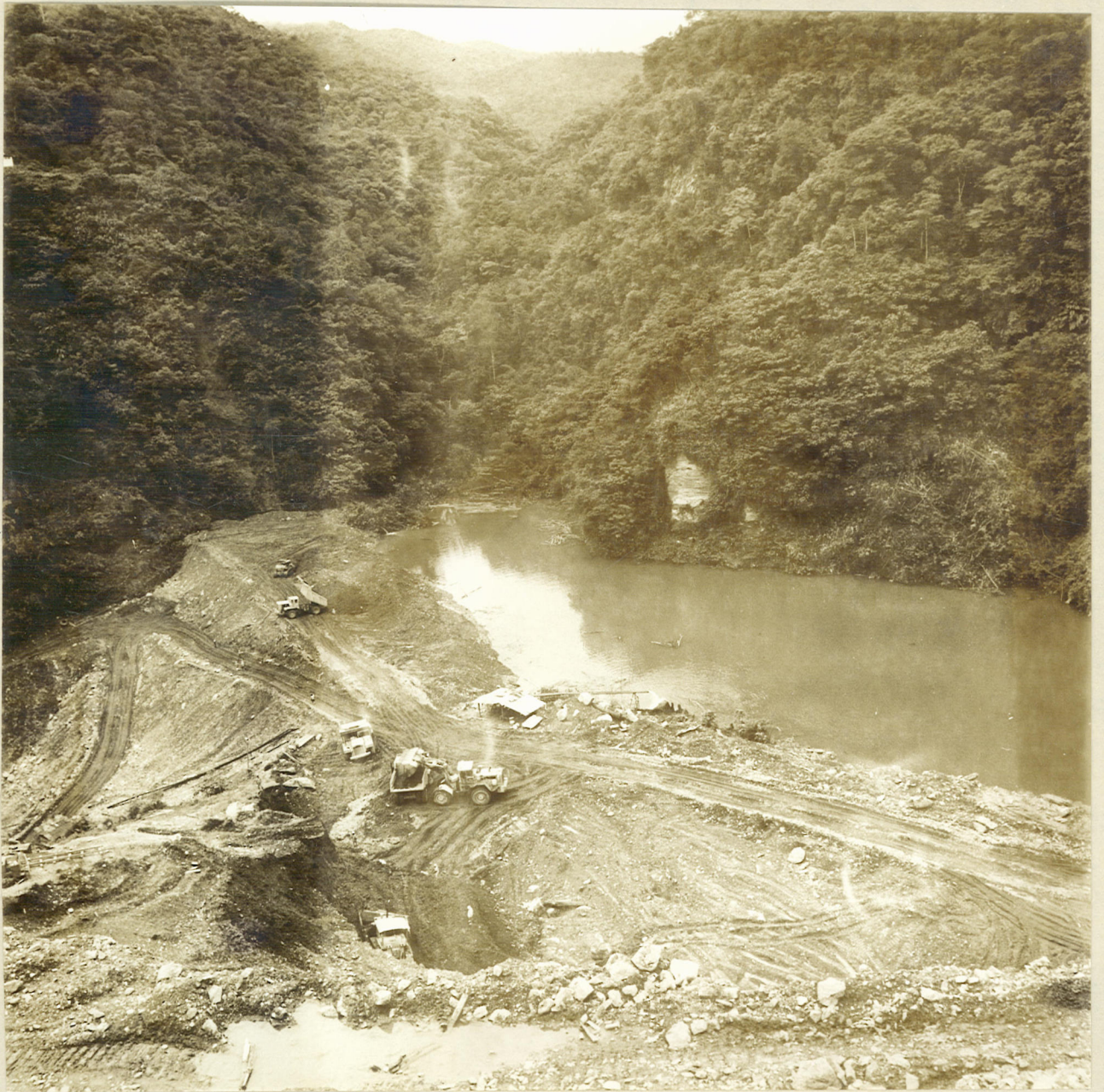
1.- ATAGUIA DE AGUAS ARRIBA DE LA PRESA Proceso de sellamiento con material impermeable
