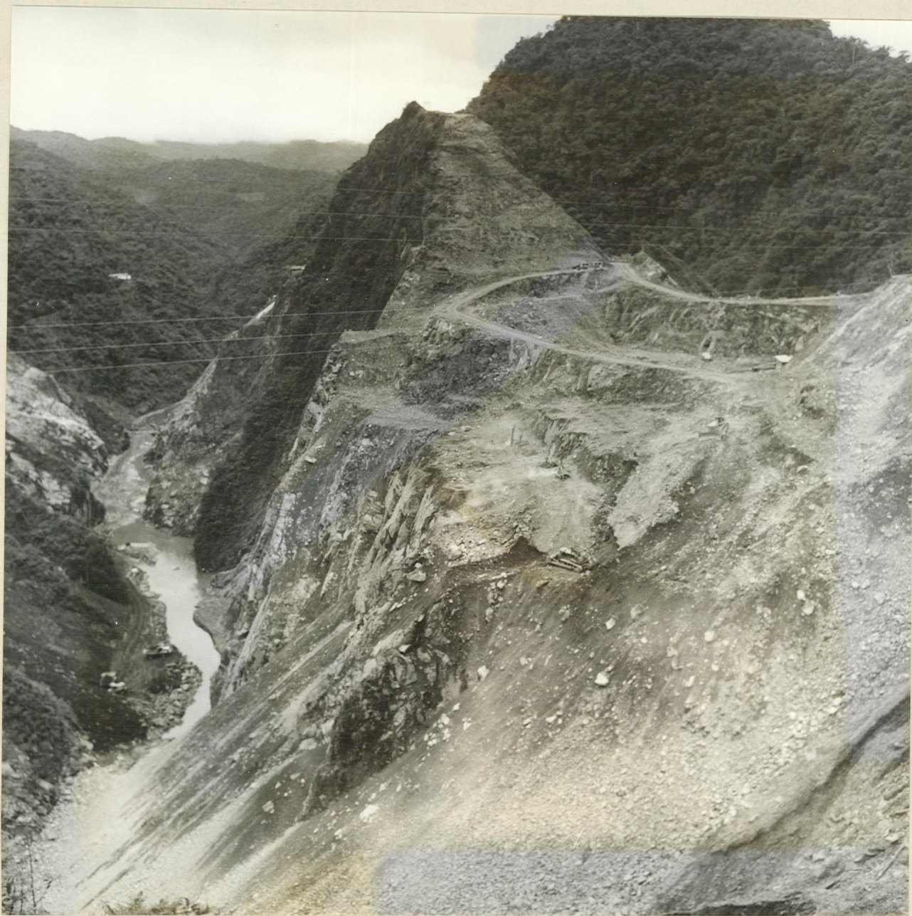
2.- REBOSADERO Estado de la excavación
