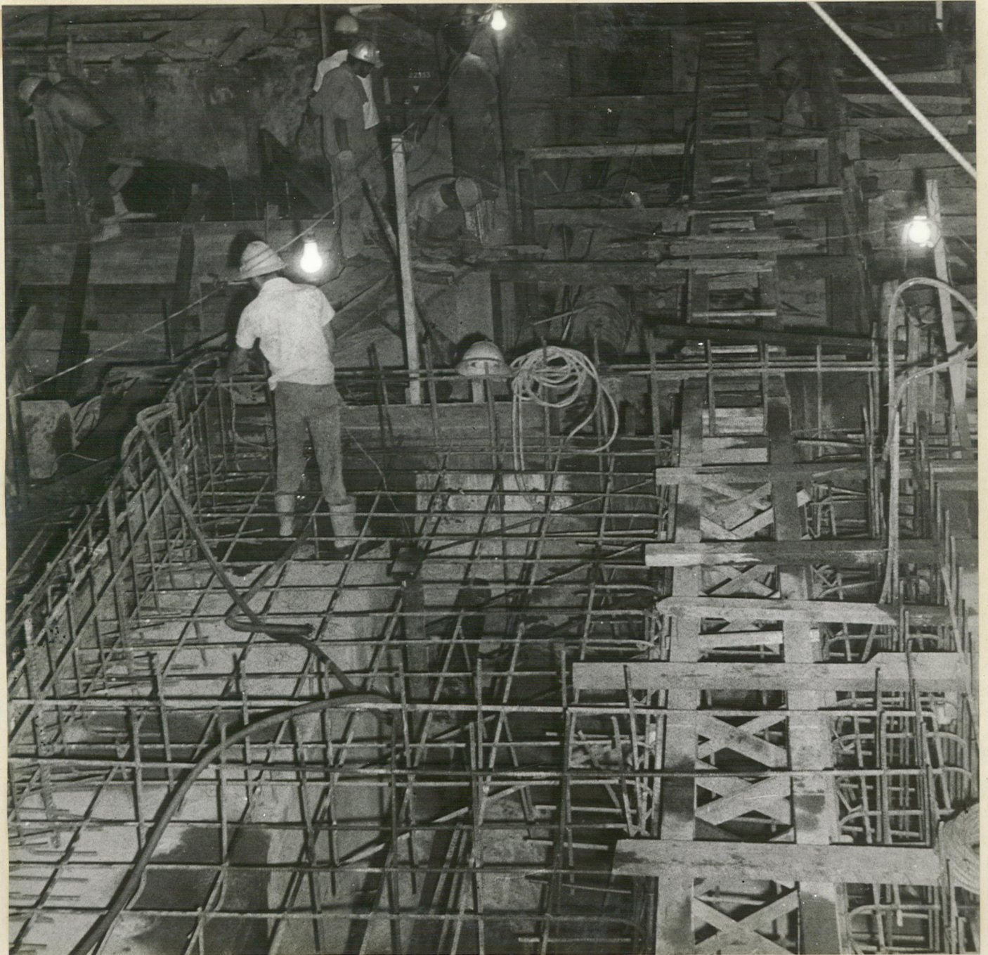
5.- GALERIA DE TRANSFORMADORES Preparación Colado del Piso
