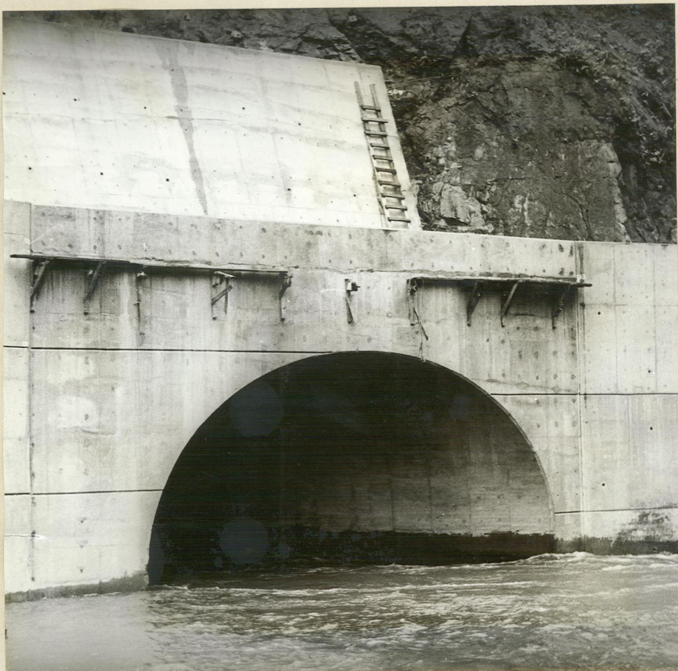
2.- TUNEL DE DESVIACION Portal de Salida
