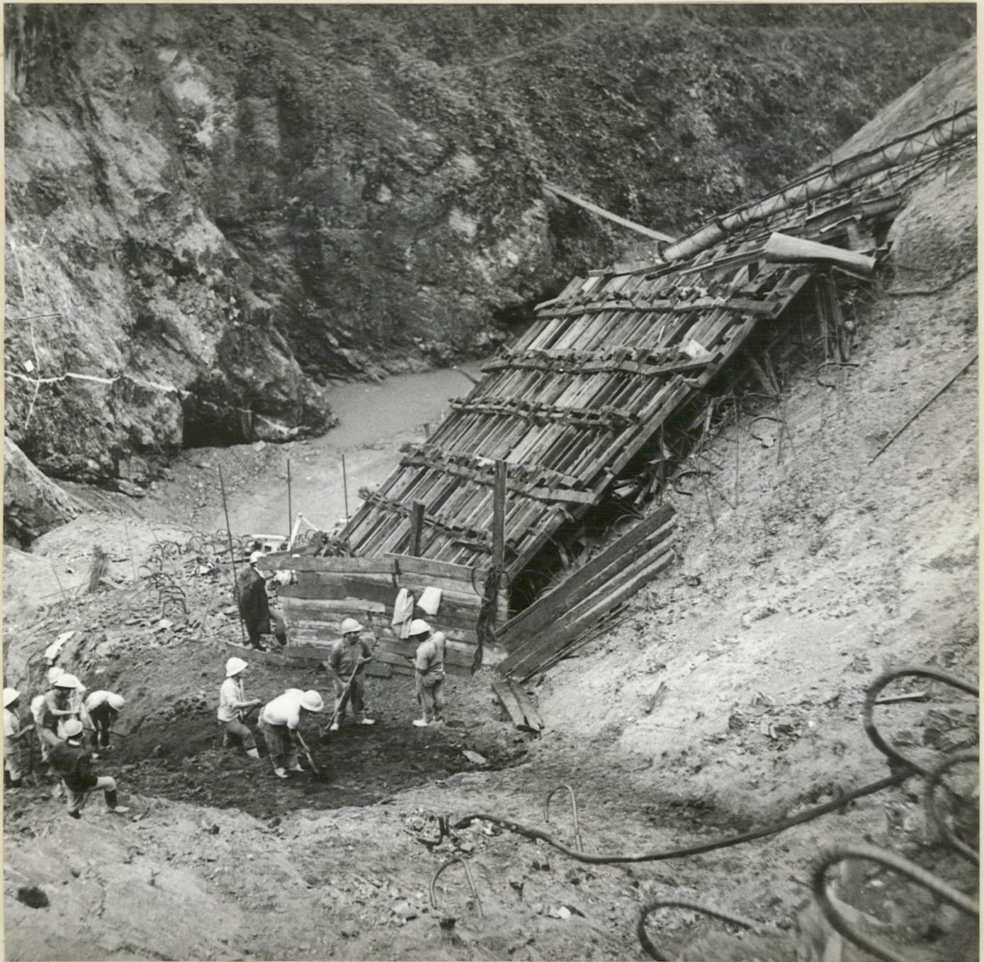
3.- PRESA - ESTRIBO IZQUIERDO Formaleta para concreto de la Pared.
