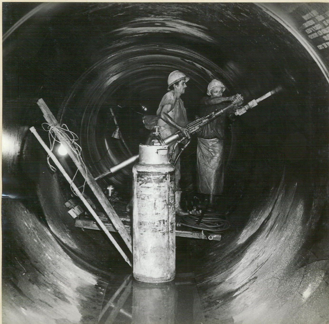
4.- TUBERIA DE PRESION Inyección de la Roca
