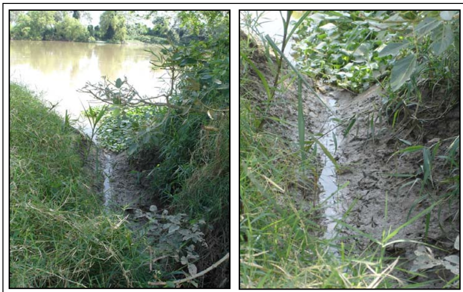
Foto 8. Deposición de Sedimentos en el Canal de Comunicación Río Cauca – Humedal El Cocal (Enero 28 de 2006).
