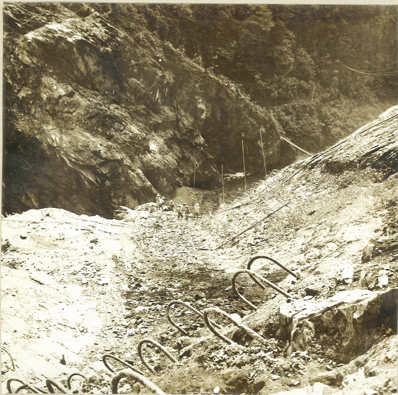
1.- PRESA PRINCIPAL Pernos de Roca en la Excavación del Estribo Izquierdo.
