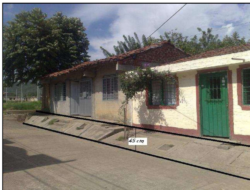
Foto 3.6 Viviendas asentadas sobre un andén de 45 cm altura sobre la calle el cual reduce la probabilidad de que el agua penetre en las viviendas.
