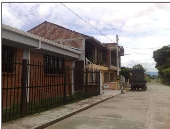
Foto 3.1 viviendas de tipo mampostería, en ellas predominan materiales mampuestos tipo ladrillo.
