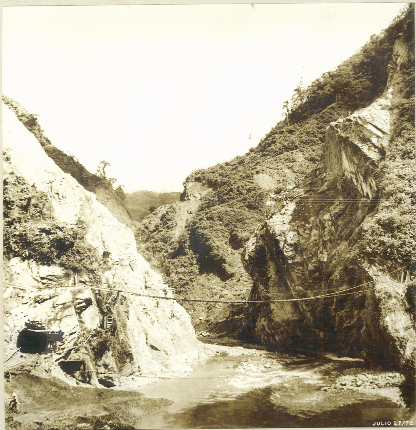
1.- AREA DE LA PRESA Portal Túnel de Acceso LC-5, Instalación Pernos de Roca en Estribo Izquierdo, Amacize en el Estribo Derecho
