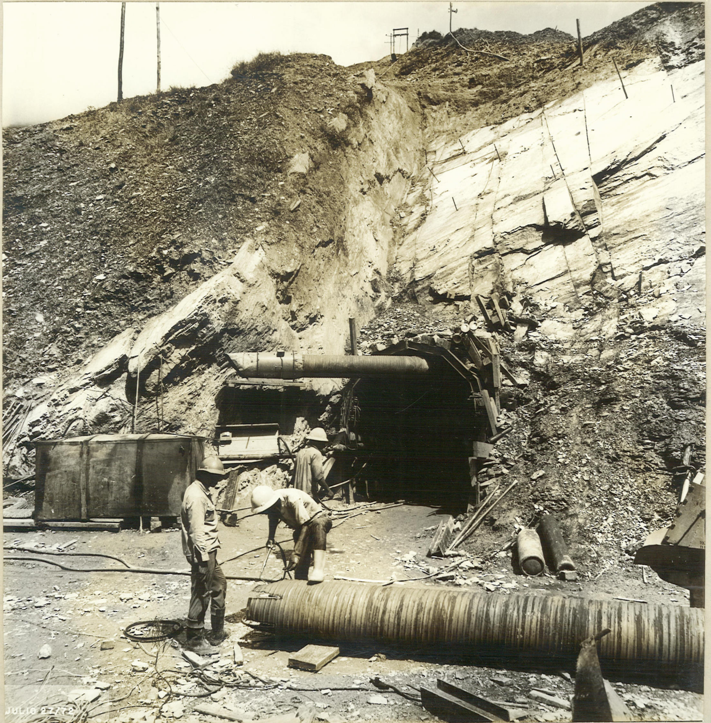
2.- AREA DE LA PRESA Galerías de Inyecciones Portal Túnel de Acceso LC-3
