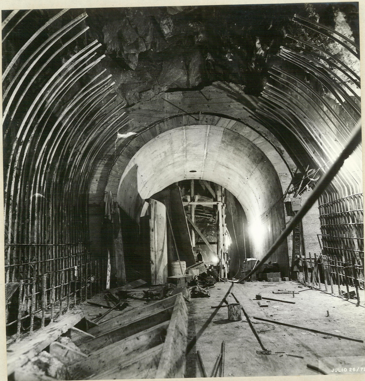
7.- CASA DE MAQUINAS Tubo de Aspiración No. 1 Vista hacia aguas arriba.
