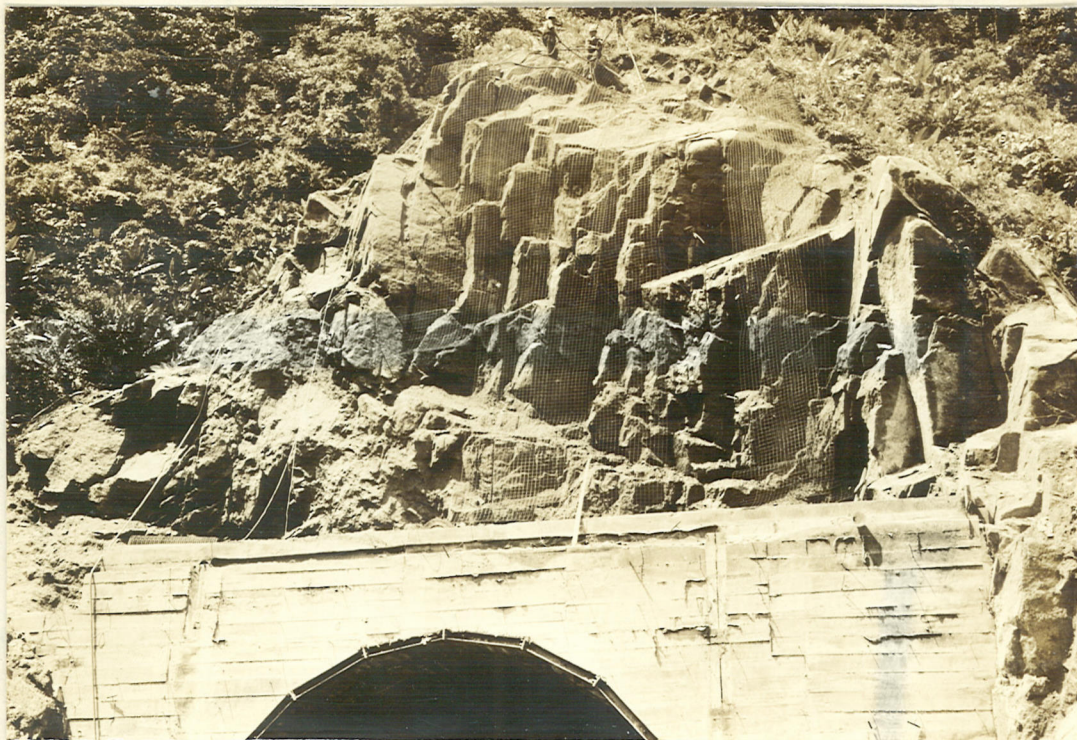
2. FORMACION DE ROCA ENCIMA DEL PORTAL CASA DE MAQUINAS
