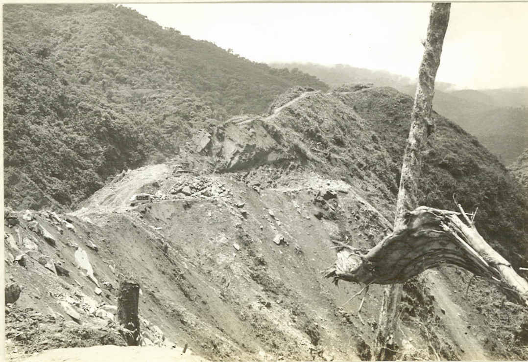
8. EXGAVACION EN EL AREA DEL REBOSADERO LADO SUR
