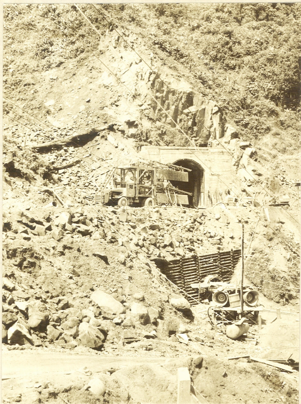
1. PORTAL CASA DE MAQUINAS CON PORTAL CM-2 POR DEBAJO
