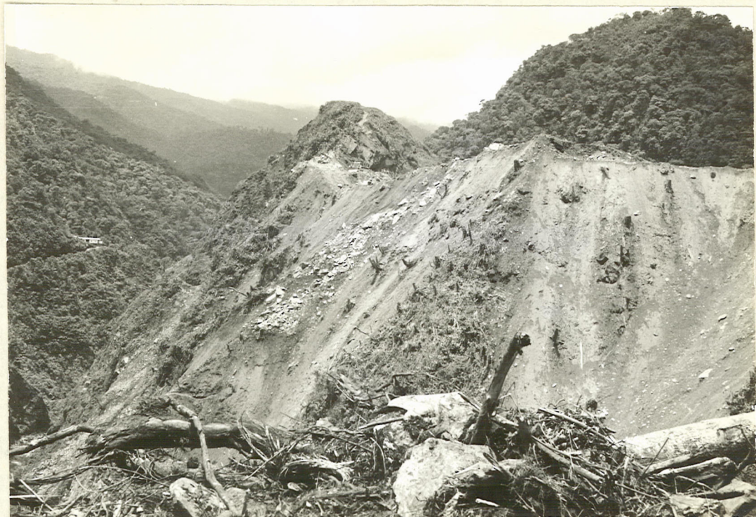
7. EXCAVACION EN EL AREA DEL REBOSADERO LADO NORTE
