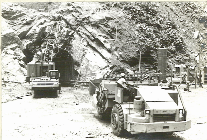
PORTAL TUNEL DE ACCESO MURRAPAL
