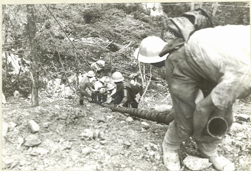
INSTALACION DE TUBO DE 4" HACIA PORTAL DE ENTRADA DEL TUNEL DE DESVIACION
