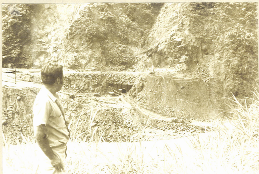
AREA DEL PORTAL CASA DE MAQUINAS
