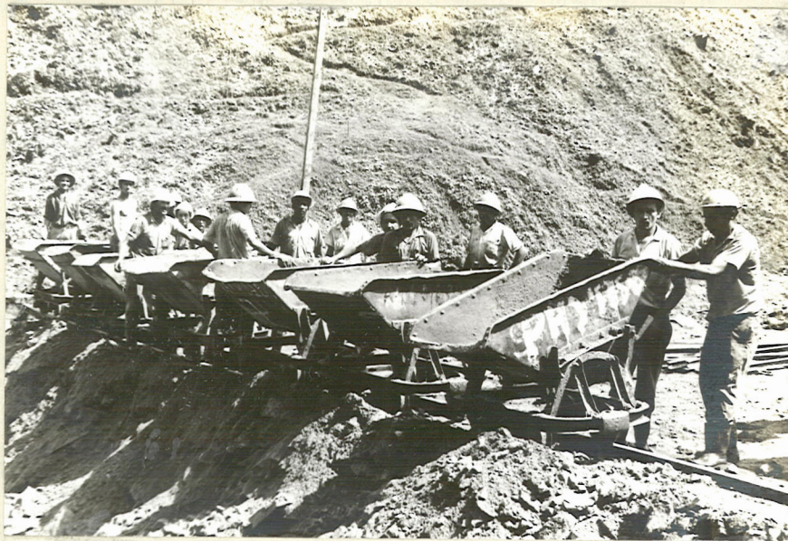
EXTRACCION DE ROCA DE LA BOVEDA CASA DE MAQUINAS
