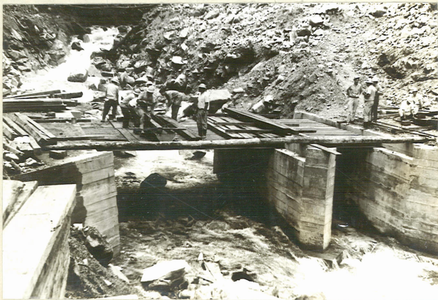
PUENTE FRENTE DEL PORTAL LA RIQUEZA
