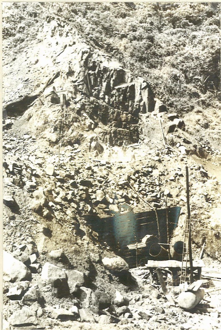
PORTAL CASA DE MAQUINAS CON PORTAL CM-2 POR DEBAJO
