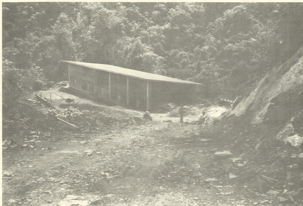
FOTOGRAFIA # 8: CARRETERA AL SITIO DE LA PRESA Polvorín de ICA en el km. 12+000.
