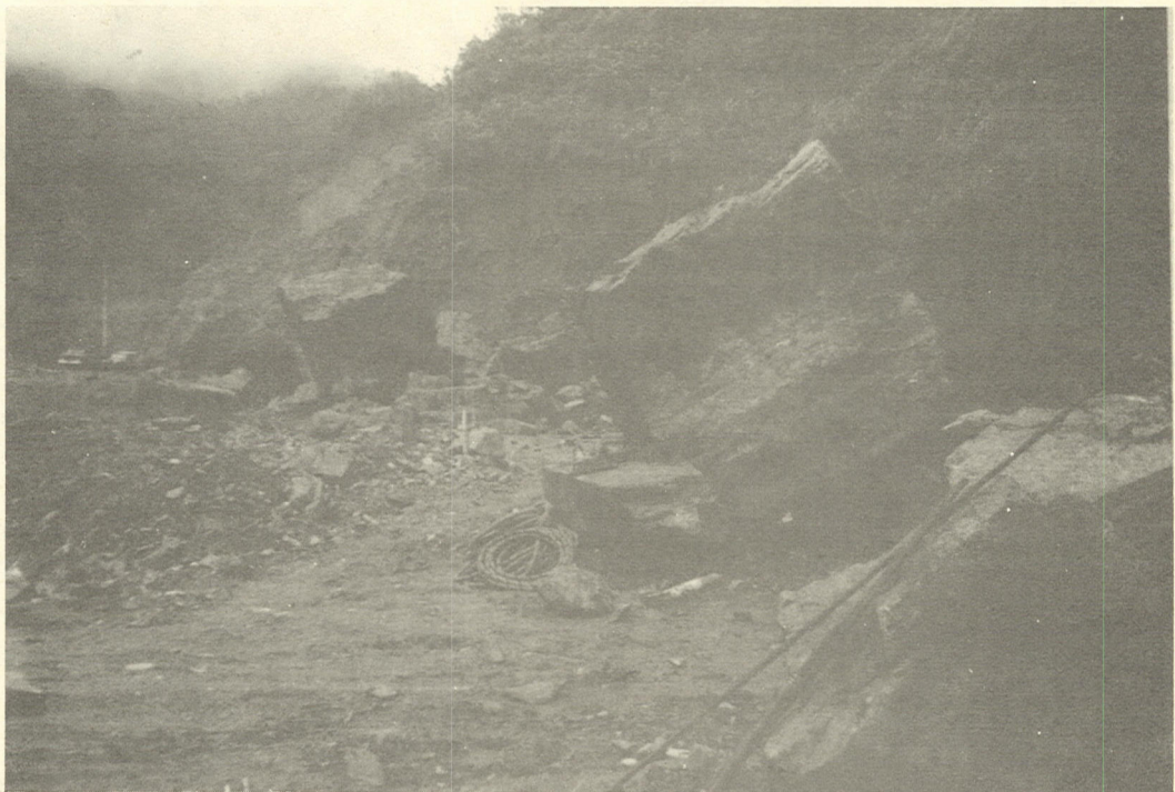
FOTOGRAFIA # 2: CARRETERA AL SITIO DE LA PRESA Derrumbe en el km. 1+000.
