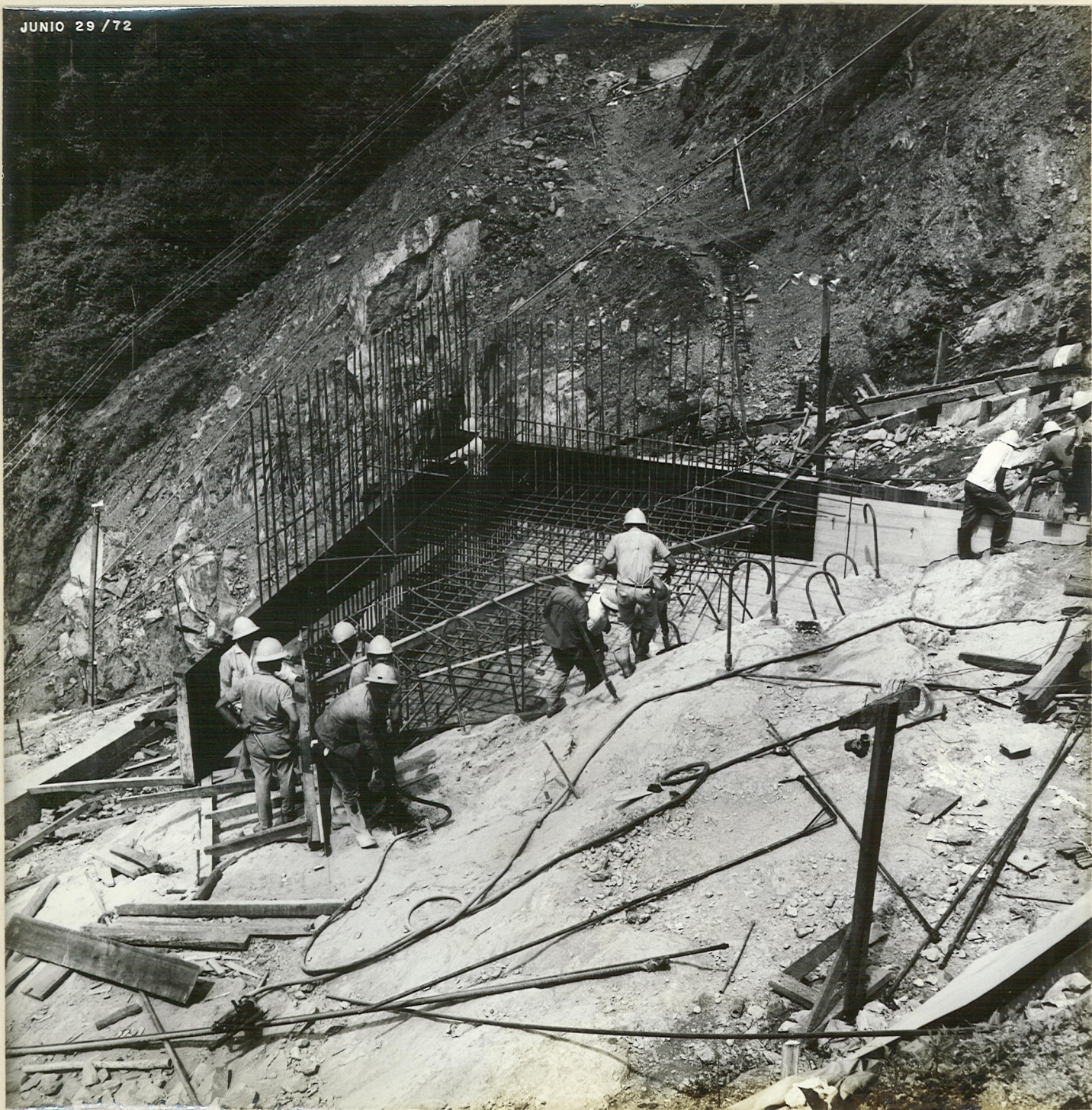
3.- BOCATOMA Estribo del Puente
