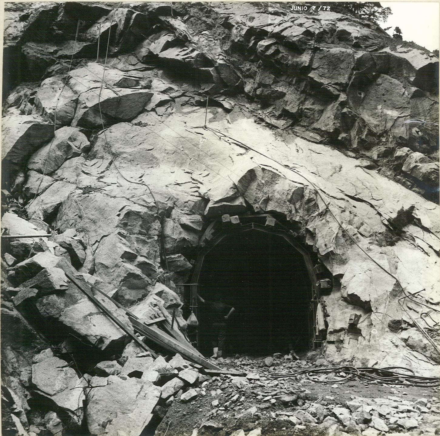
4.- CAPTACION MURRAPAL Portal Túnel de Salida
