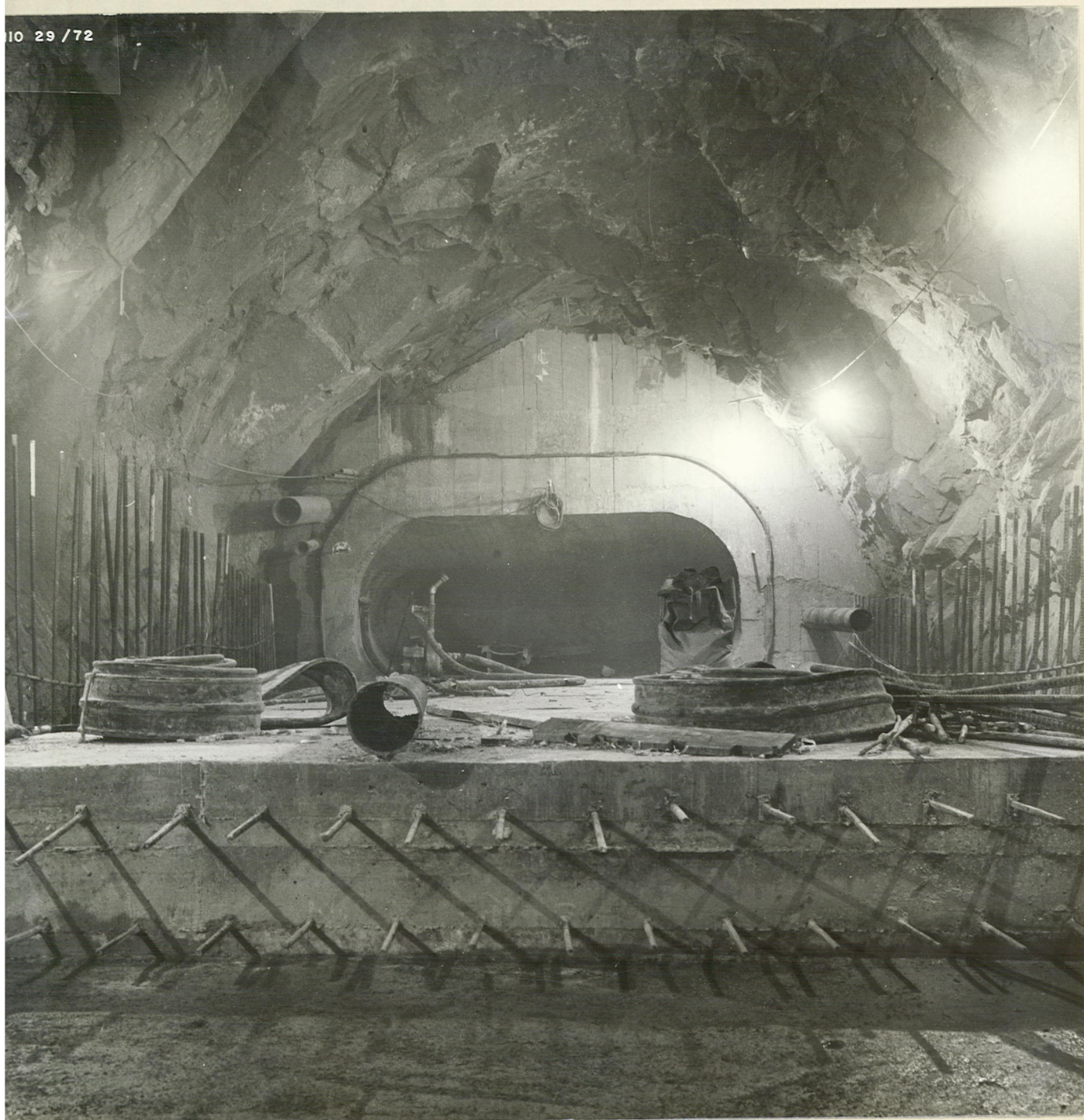
6.- CASA DE MAQUINAS Tubo de Aspiración Unidad No. 1
