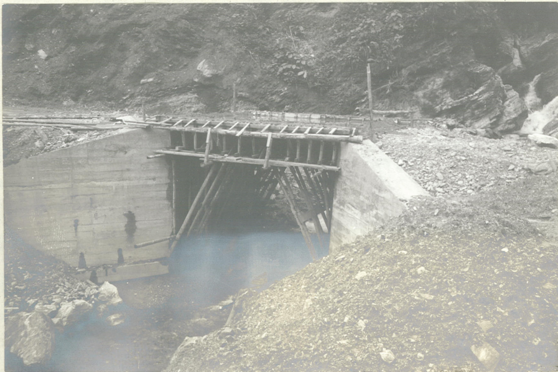
N° 4 - CARRETERA PRINCIPAL DE ACCESO. Puente sobre la Q. La Loca.
