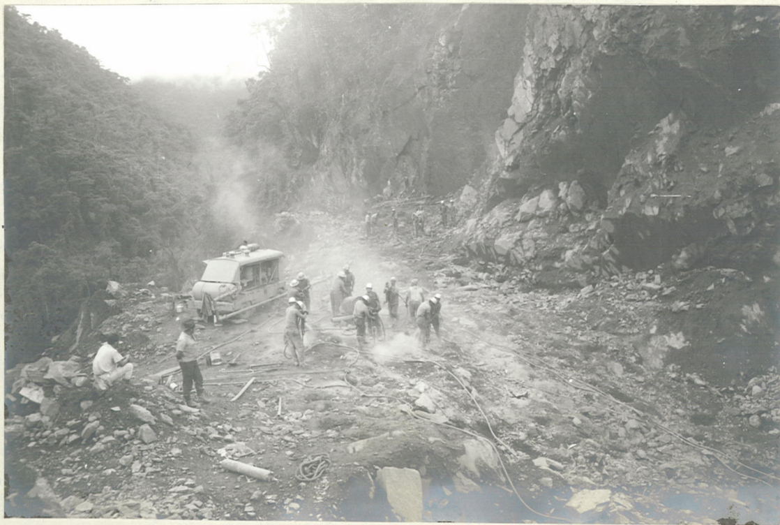
N° 6 - CARRETERA PRINCIPAL DE ACCESO. Trabajos en el Tapón de Murrupal.
