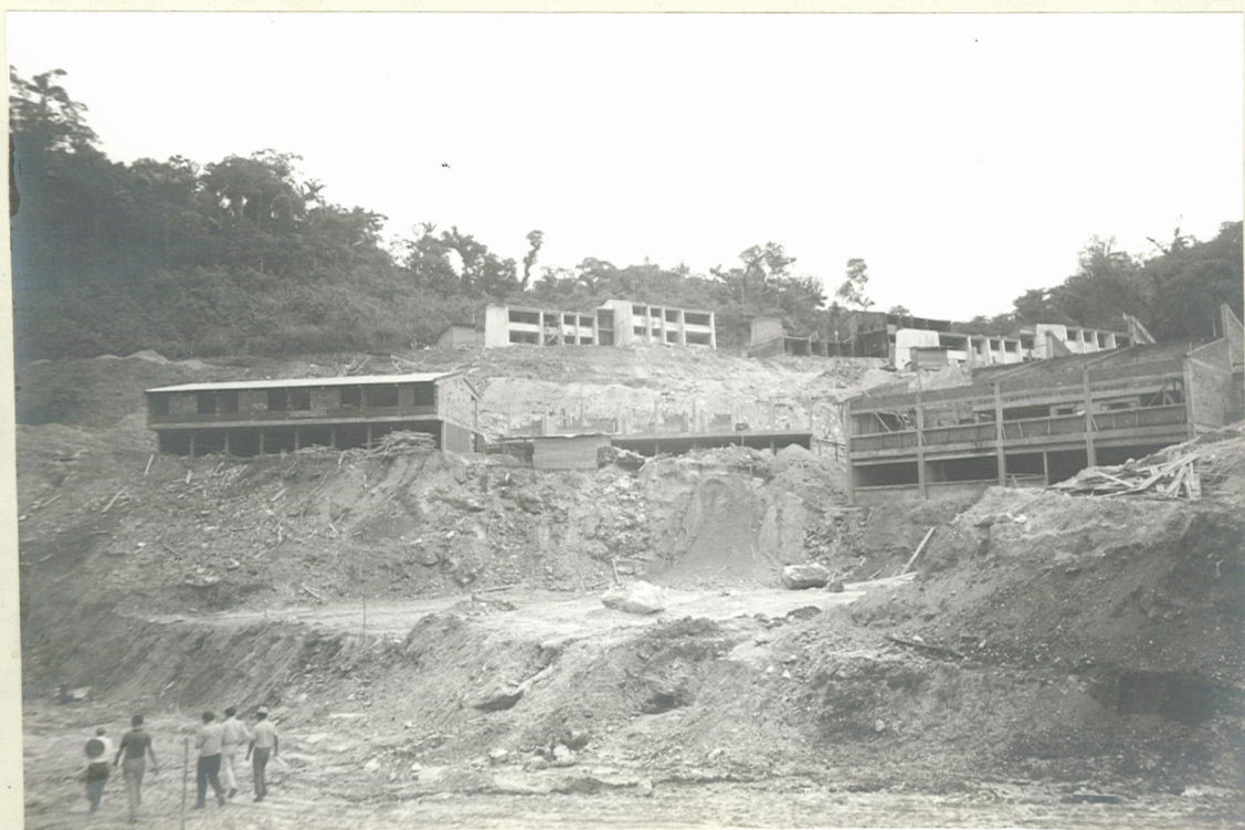
Nº 8 - CAMPAMENTO DE YATACUE. Conjunto bloque de solteros y casas tipo B.
