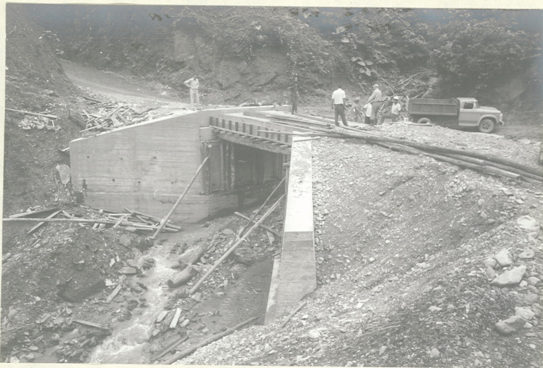
N° 5 - CARRETERA PRINCIPAL DE ACCESO. Puente sobre la Q. La Cristalina.
