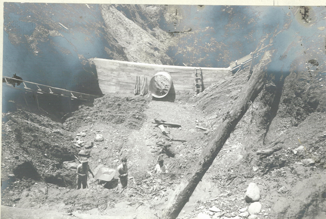
N° 3 - CARRETERA PRINCIPAL DE ACCESO. Muro de concreto en la Q. Frijolillo.
