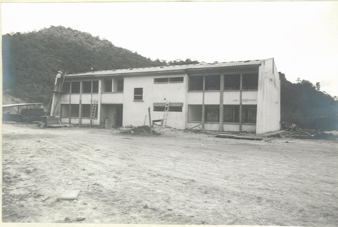
Nº 7 - CAMPAMENTO DE YATACUE. Edificios de Oficinas.
