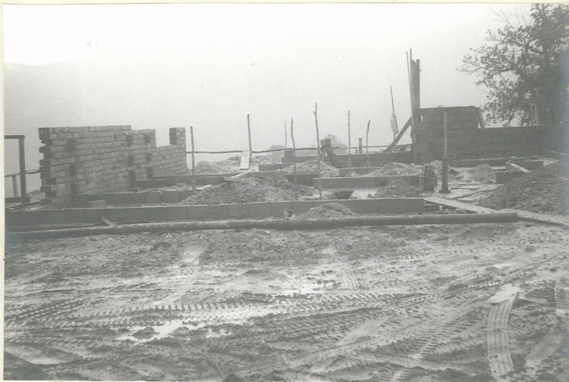
Nº 9 CAMPAMENTO DE YATACUE Aspecto de los trabajos en las casas tipo A.
