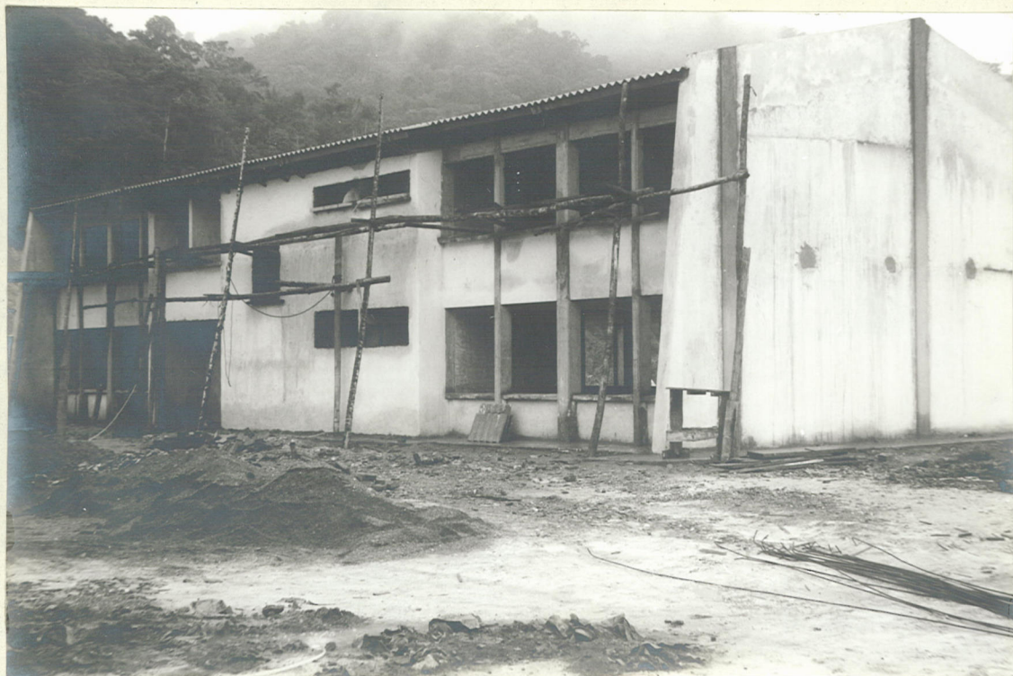
Nº 5 CAMPAMENTO DE YATACUE Vista exterior del edificio de oficinas
