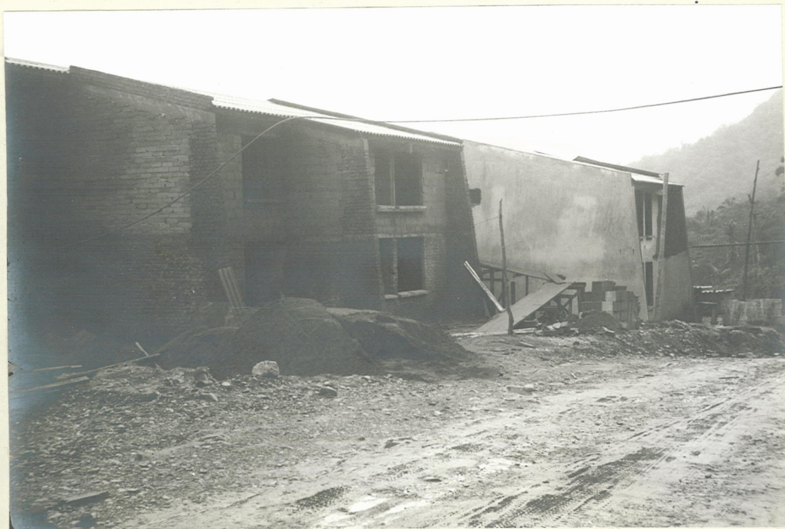
Nº 8 CAMPAMENTO DE YATACUE Aspecto de los trabajos en las casas tipo B.
