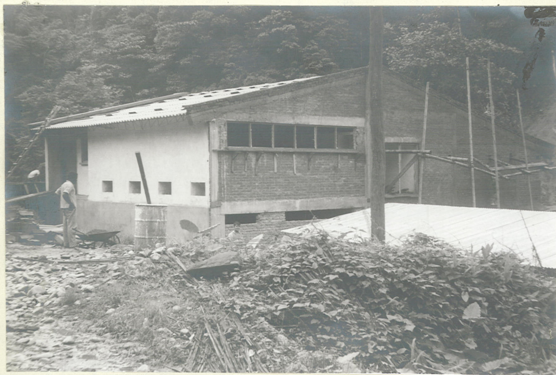
Nº 10 CAMPAMENTO DANUBIO Aspecto exterior de la obra.
