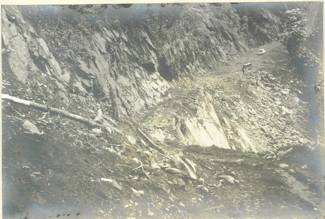
Nº 3 CARRETERA PRINCIPAL DE ACCESO Tapón de Murrupal Vista del estado actual de la vía antes de Murrupal.
