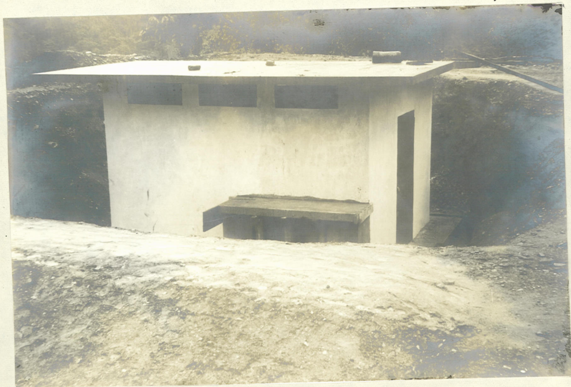
Nº 4 Polvorín Aspecto de la obra.
