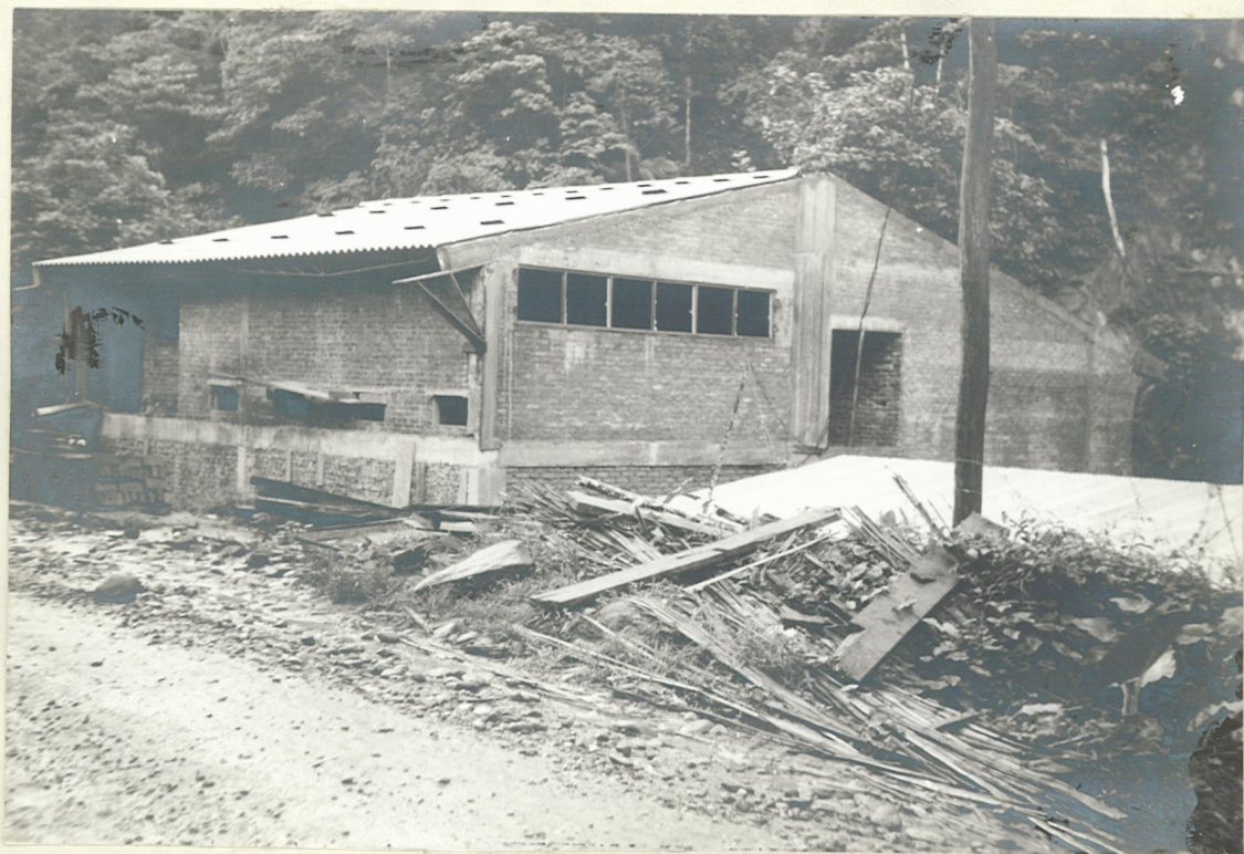
Nº 4 - Campamento de Danubio Estructura en obra negra.
