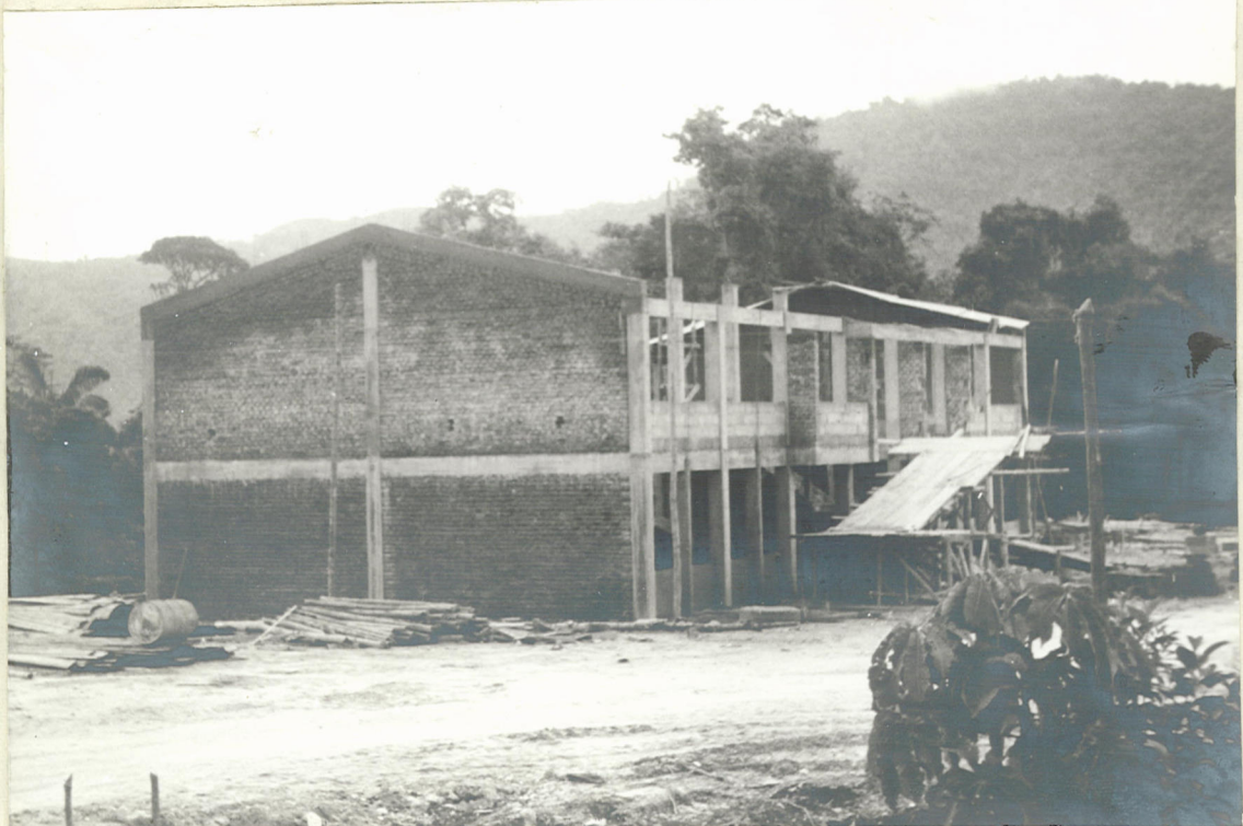
Nº 5 - Campamento de Yatacué. Edificio de oficinas.
