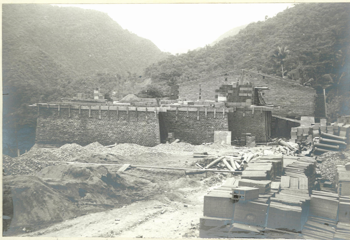
Nº 8 - Campamento de Yatacué casas tipo B.
