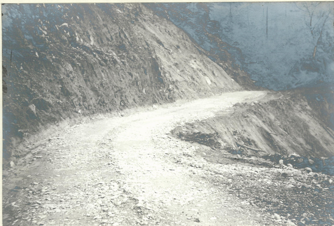
Nº 1 - Carretera principal de acceso Tramo mostrando el afirmado.
