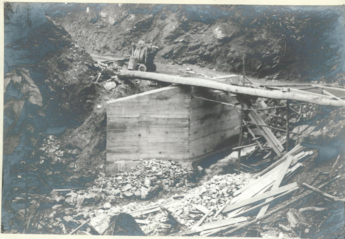
Nº 3 - Carretera principal de acceso. Puente sobre la Quebrada La Loca estribo derecho terminado e iniciación del muro en el estribo izquierdo.
