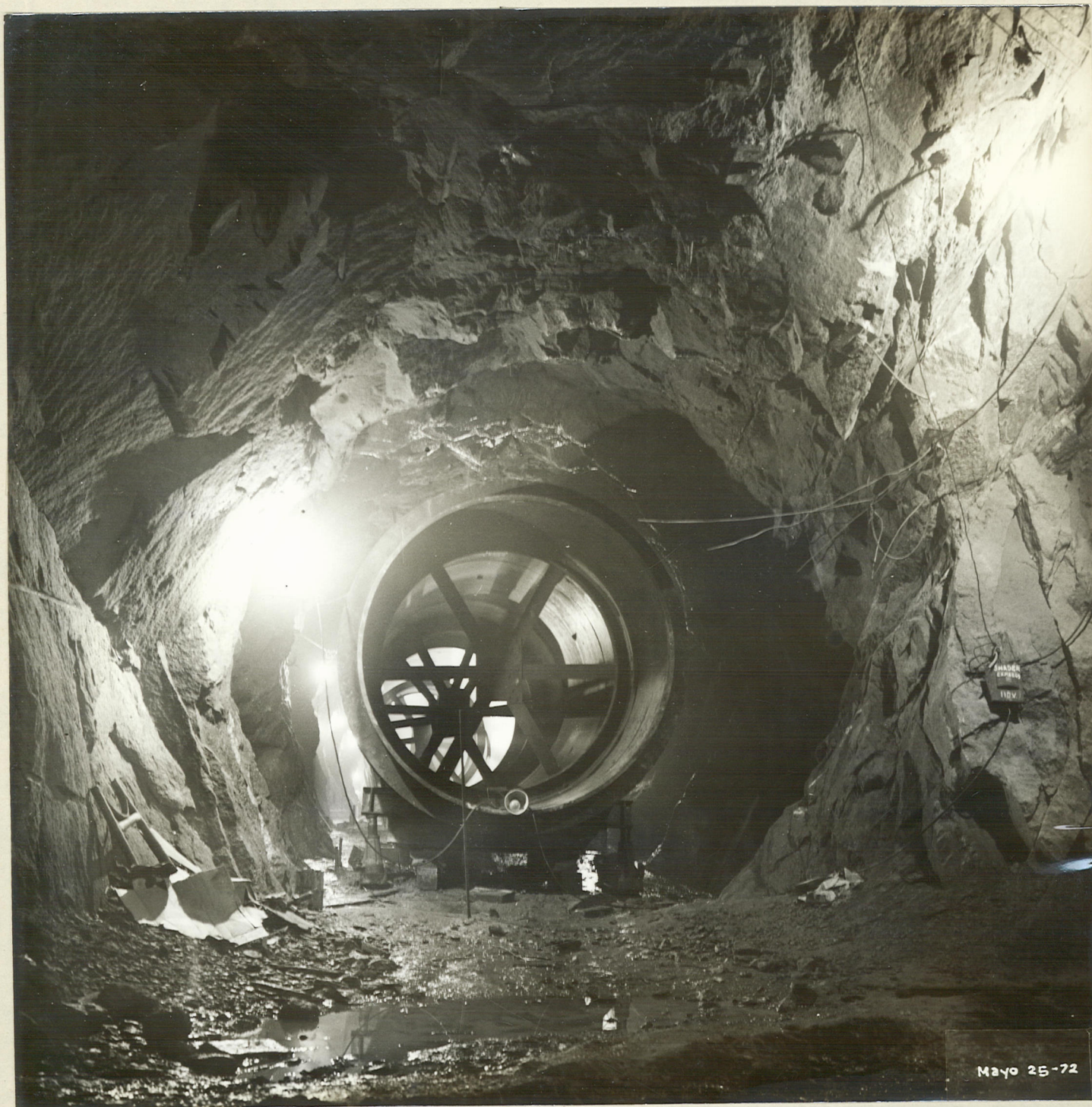
4. TUBERIA DE PRESION Blindaje para la Unidad No. 2
