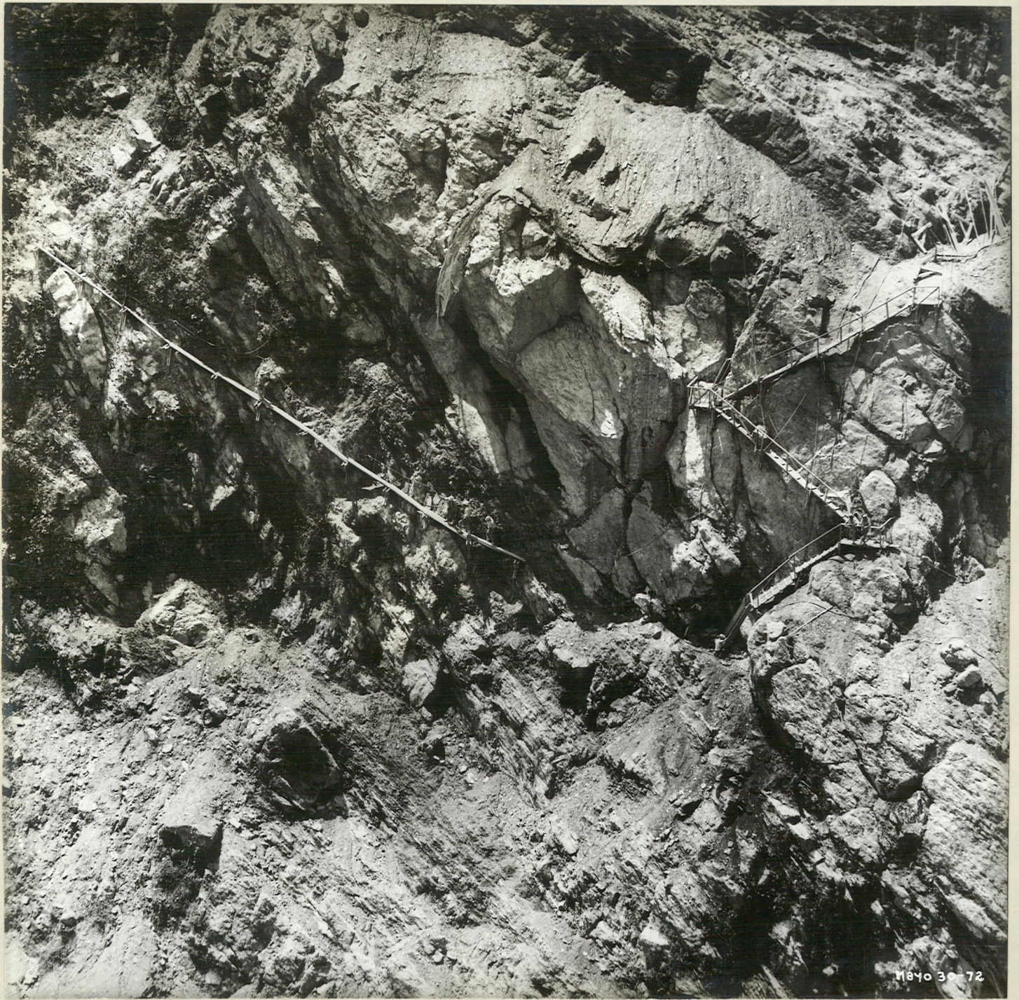
3. PRESA - ESTRIBO DERECHO Camino para investigación geológica
