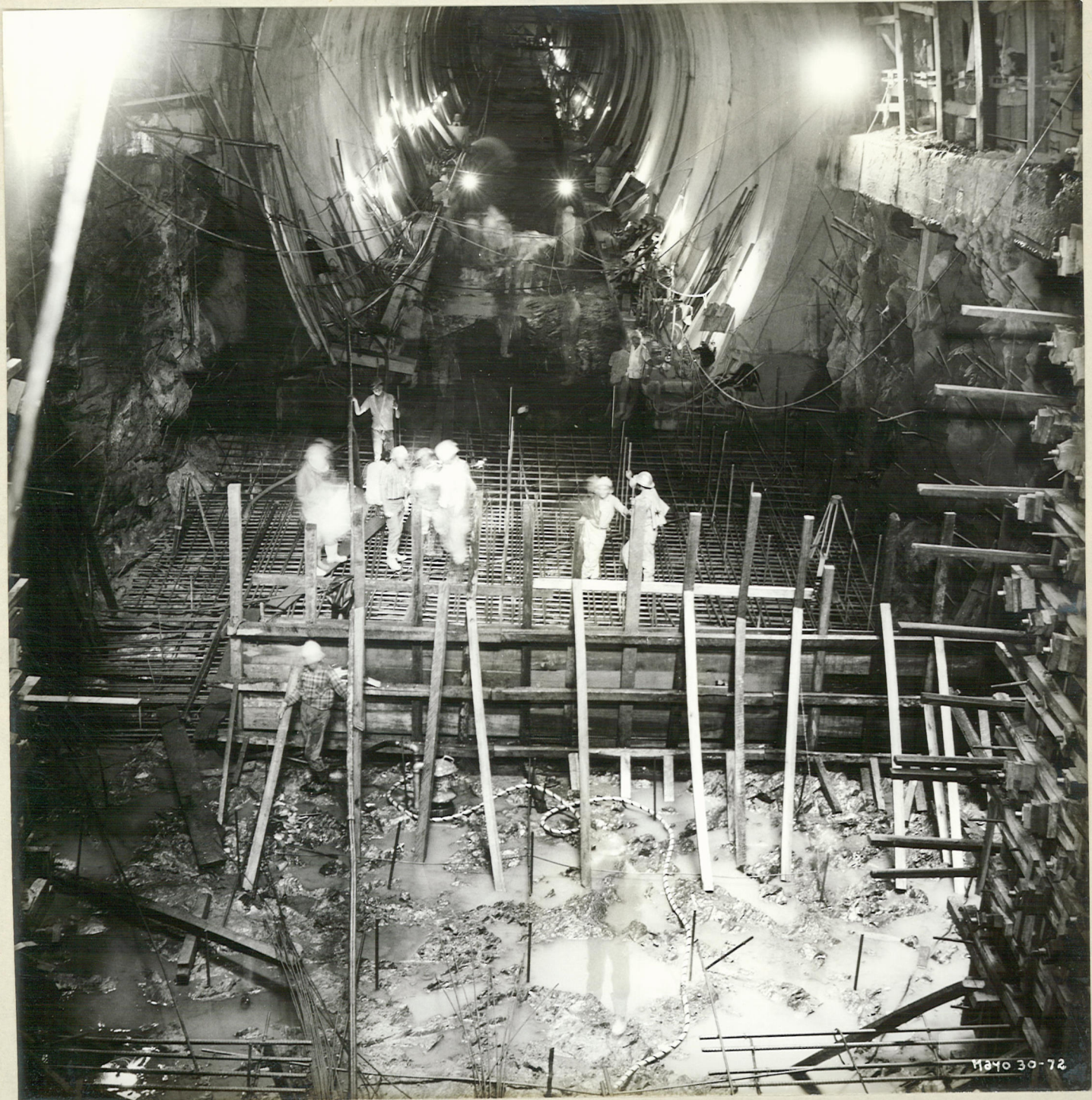
2. TUNEL DE DESVIACION Refuerzo en la Transición
