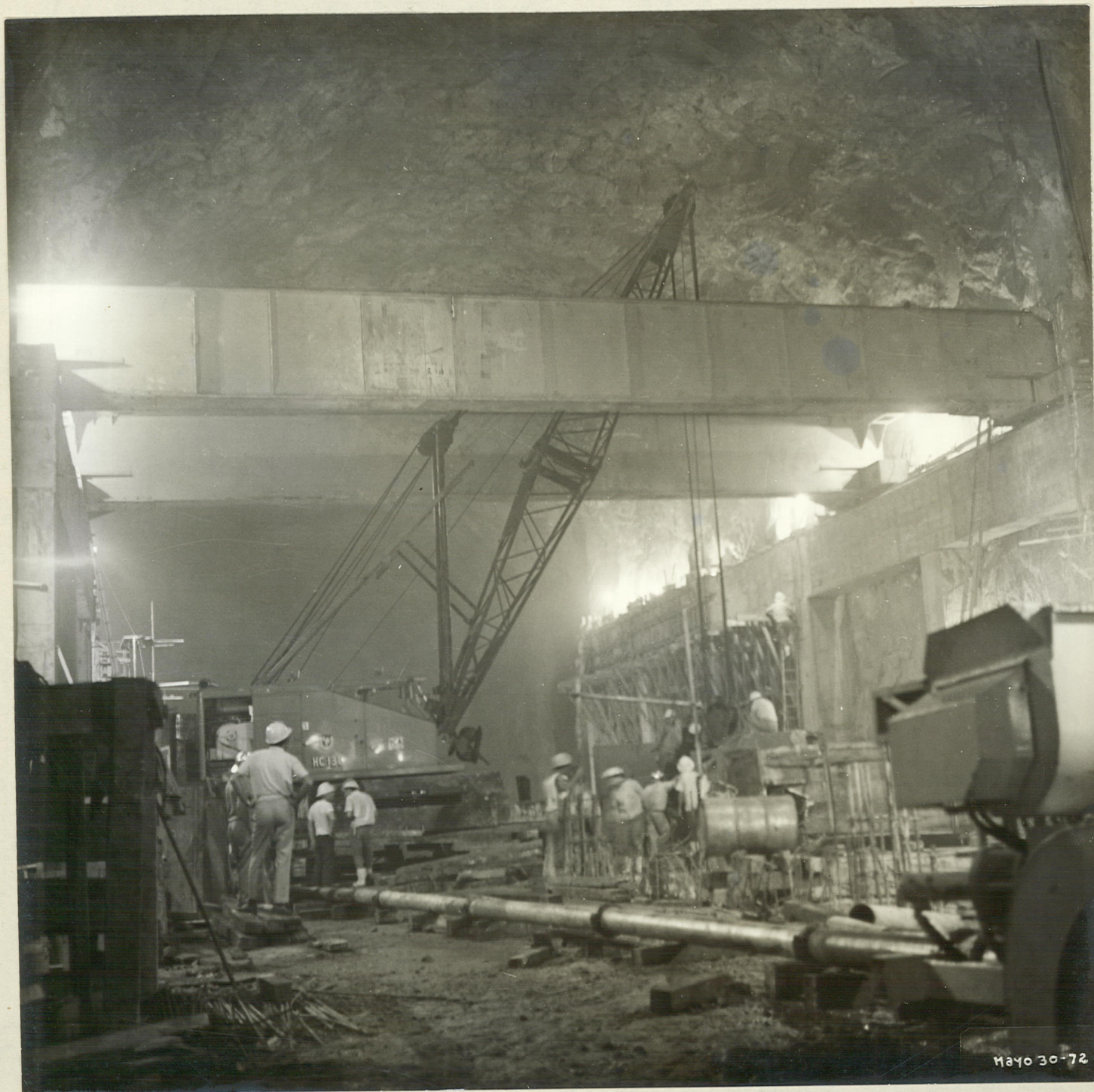
6. CASA DE MAQUINAS Montaje del Puente Grúa
