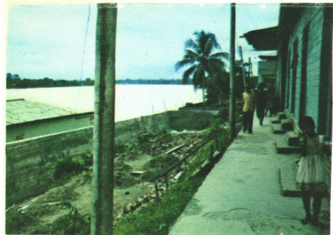
Muro de Defensa
