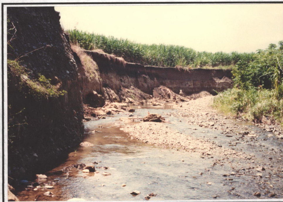
Fotografía 7.4. Actividad erosiva y de socavación lateral en la margen derecha del río Bolo, muy cerca de la zona urbana de Pradera (vista aguas arriba).
