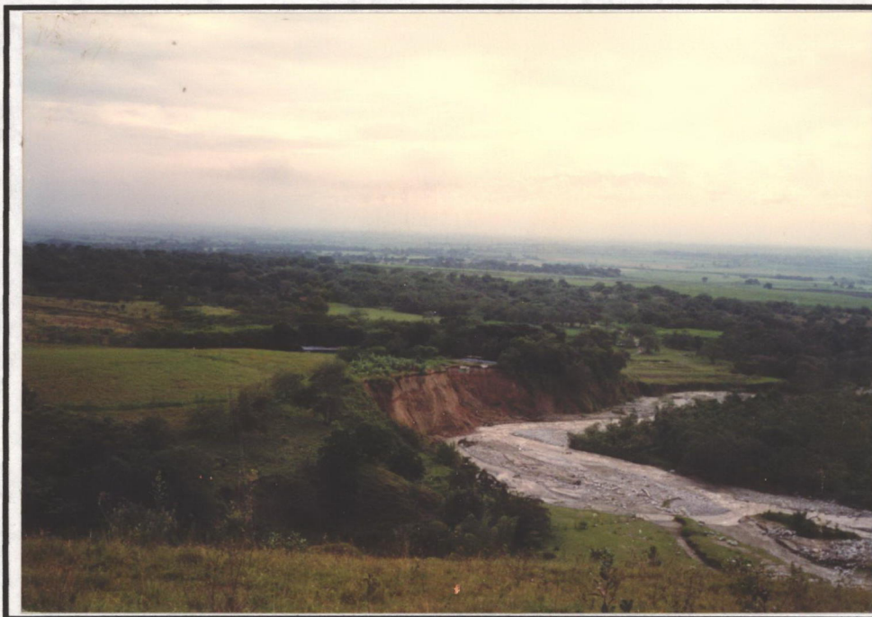
Fotografía 7.16. Obsérvese dos (2) viviendas ubicadas en la corona de un escarpe a punto de ser alcanzadas a causa de la socavación lateral. (ej. Río Fraile, aguas arriba del municipio de Florida).
