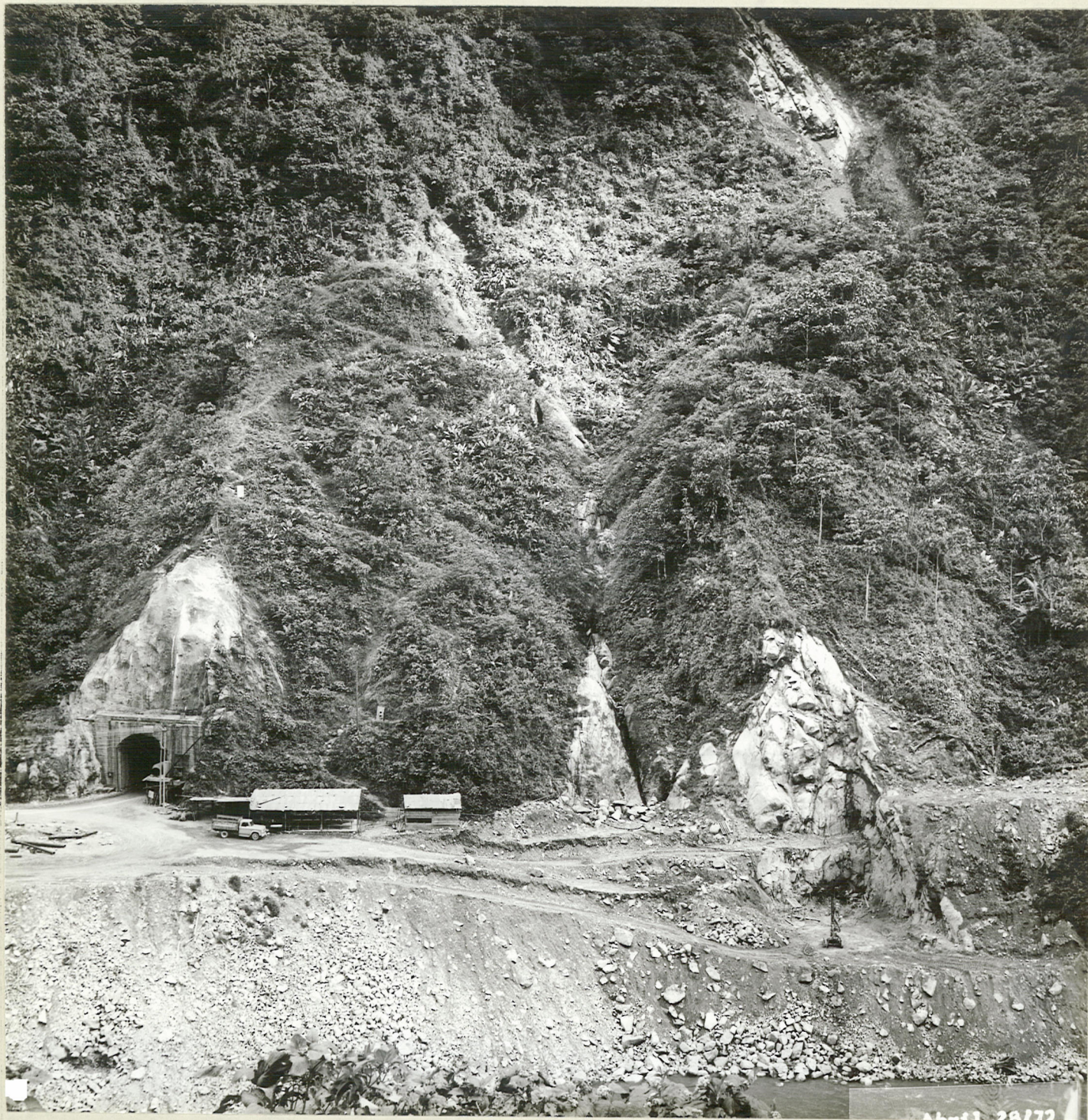
4. TUNEL DE FUGA Excavación del Portal
