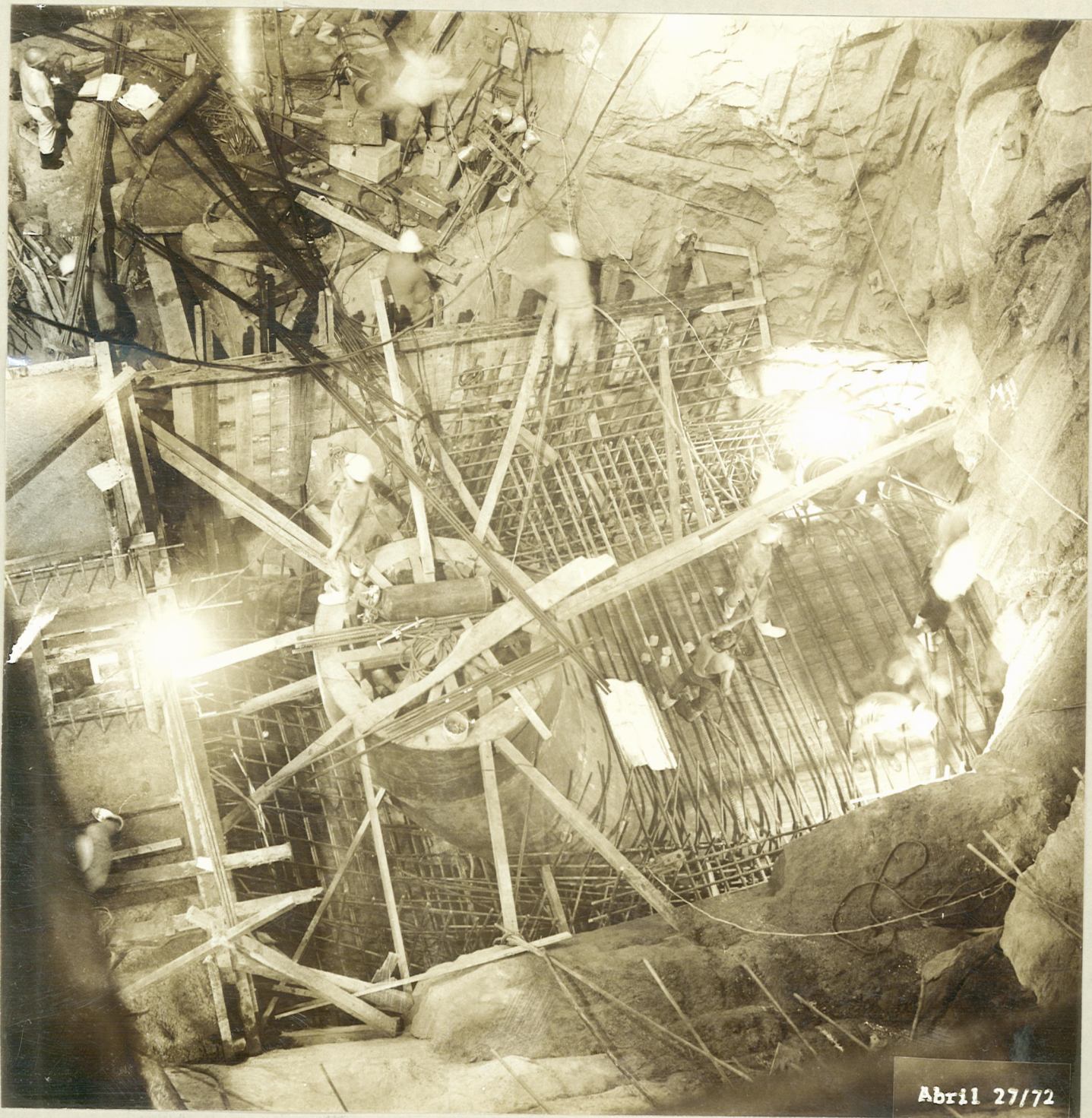
1. CASA DE MAQUINAS Tubo de Aspiración - Unidad No. 1
